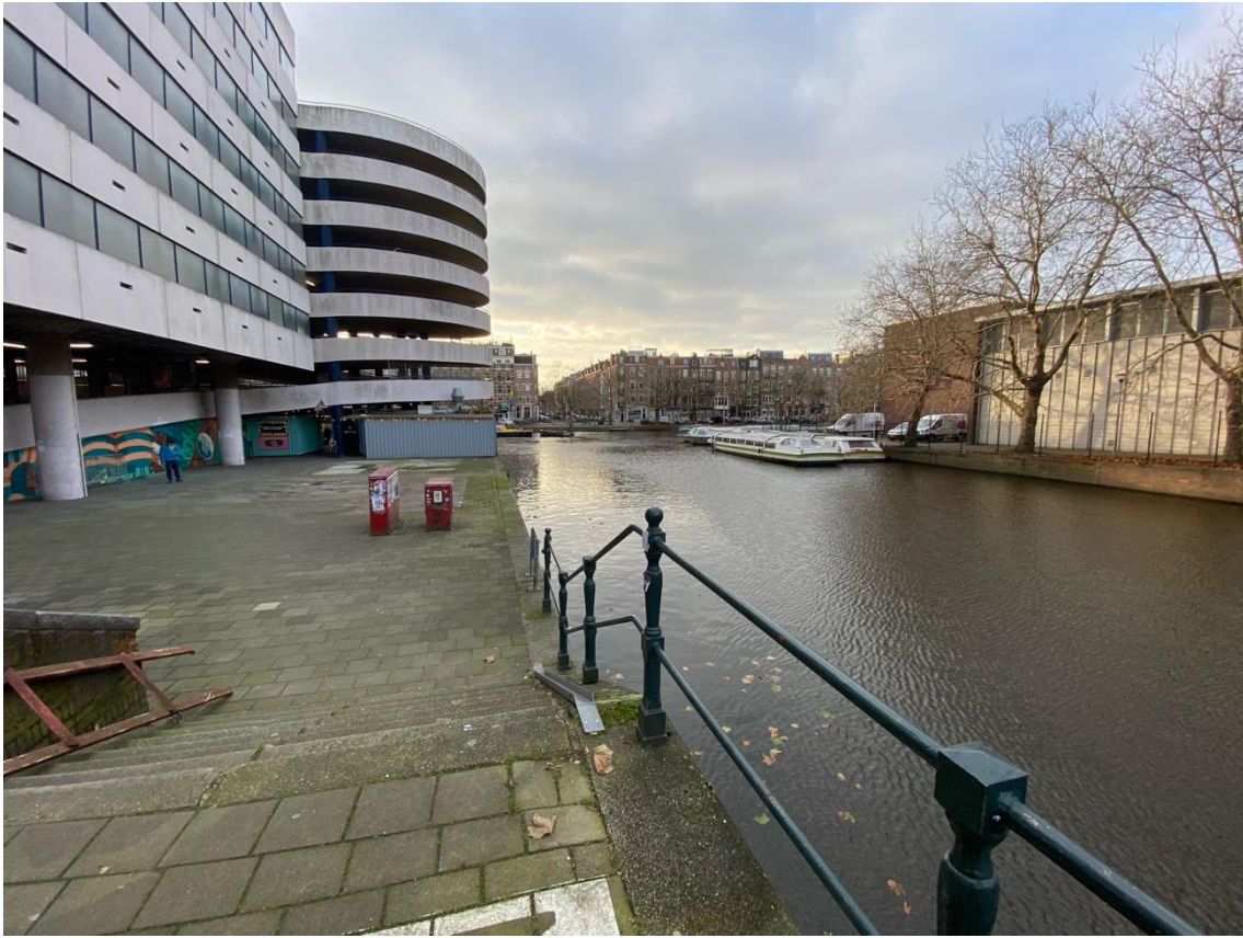
Zicht op lage kade vanaf hoge kade. De nutsvoorzieningen zullen waarschijnlijk tzt verwijderd moeten worden bij realisatie van de logistieke hub.
