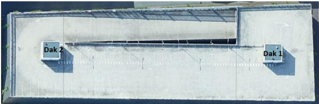
0781 Santiagogarage (daken trappenhuizen, op/afritten en eventueel aanwezige bakgoten/luifels), Santiagostraat 3, 1334HH Almere Buiten
