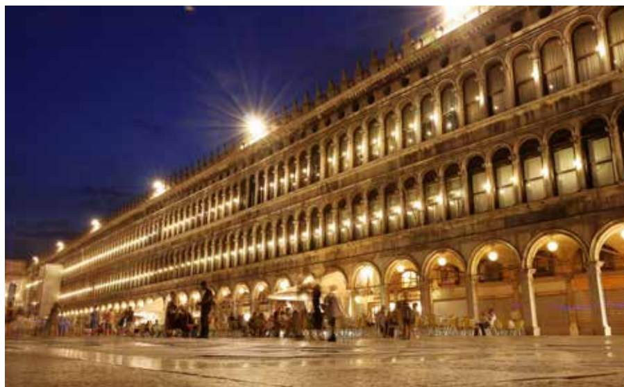
basisverlichting plein vanuit gevels
