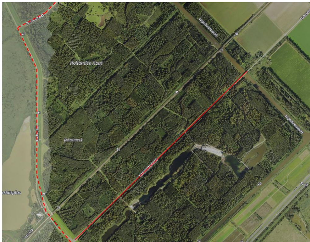
Omleiding doorgaand fietsverkeer tijdens werkzaamheden Torenavalkweg in Hollands Hout
