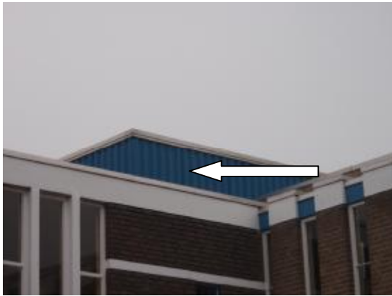
Foto 2: Het dak is in verband met hoogte niet onderzocht. Hier zijn mogelijk golfplaten aanwezig.
