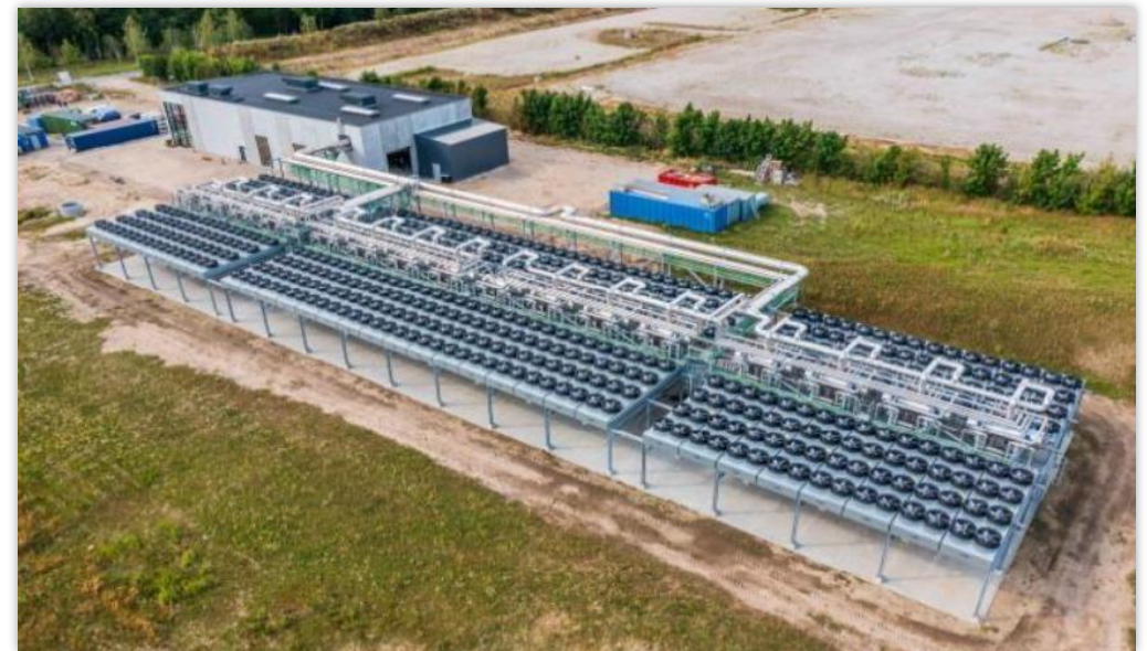
Water-water warmtepompcentrale van 27 MW in aanbouw. (bron: duic.nl)
