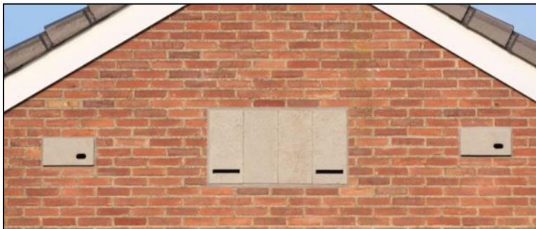
Afbeelding 6: inbouwkasten voor vleermuizen en vogels. Bron: Unitura.nl
