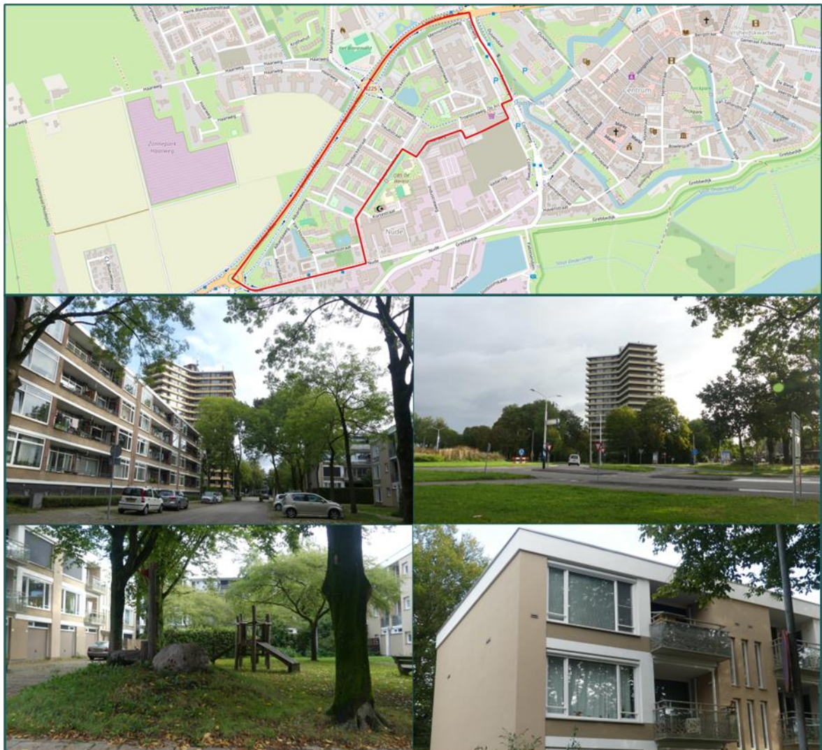
Figuur 4.2 Linksboven: de typische bouwstijl in deze buurt (hoogbouw). Rechtsboven: sterflat. Linksonder: typisch parkje tussen de hoogbouw. Rechtsonder: inbouwvoorzieningen voor vleermuis in de recent gerenoveerde hoogbouw.
