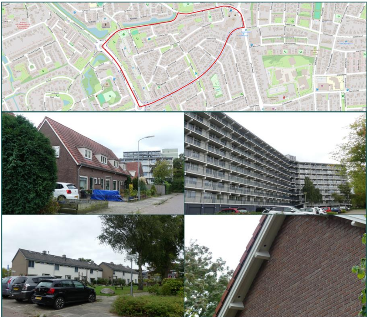
Figuur 4.17 Linksboven: typische bouwstijl in deze buurt (rijtjeswoningen). Rechtsboven: hoogbouw aan de westzijde van de buurt. Linksonder: het groen bestaat uit enkele parkjes in de buurt. Rechtsonder: er zijn veel woningen met faunavorzieningen in de dakoverstekken in deze buurt.
