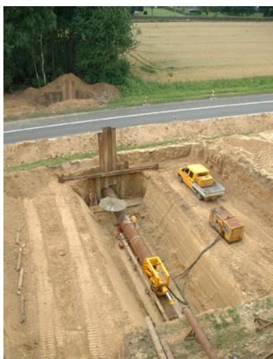
Boorput van een OFT (Open Front Techniek, Rijksweg 79)
