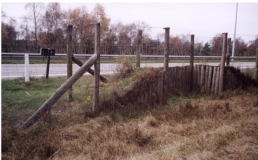
Inspringvoorziening met kort, geleidend raster aan de wegkant
