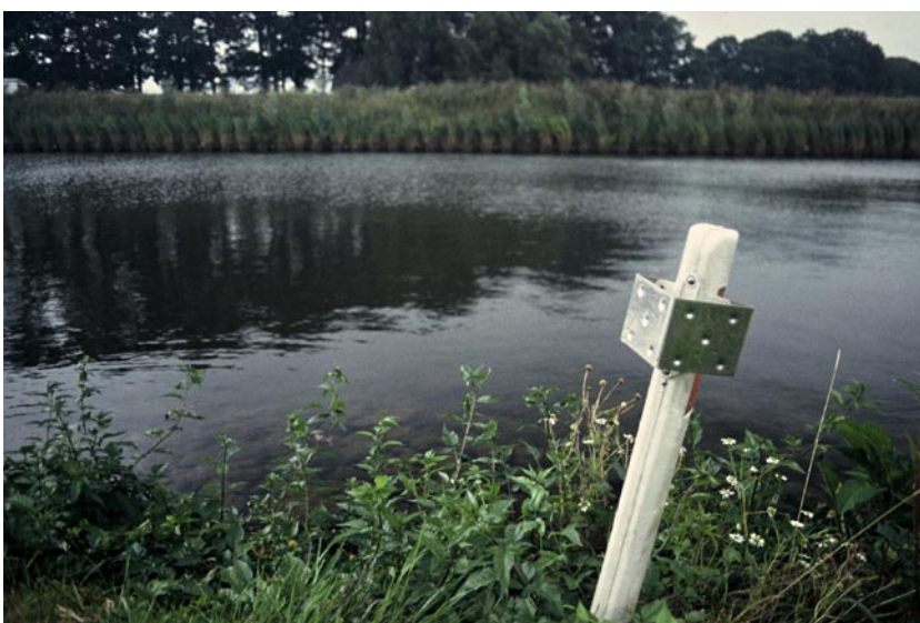
Scheefstaande wildspiegel kan niet functioneren
