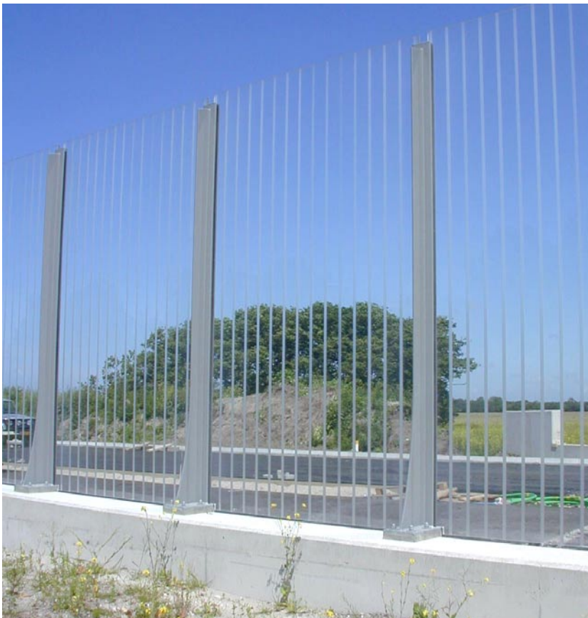
Transparante geluidsschermen met vertical markering
