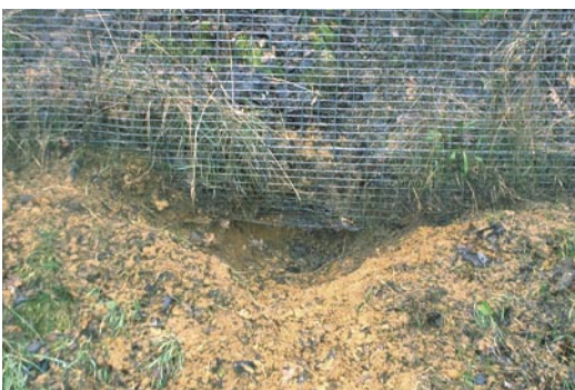
Raster is ondergraven; sluit niet meer op maaiveld aan
