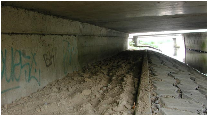
Onverharde strook onder brug, talud met basaltblokken verstevigd
