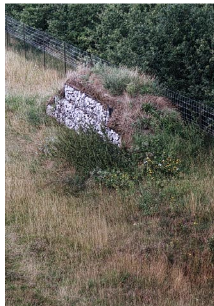
Inspringvoorziening. Een kort raster tegen de heuvel aan, evenwijdig aan het lange raster kan wellicht voorkomen dat dieren er omheen lopen en de terugkeermogelijkheid missen
