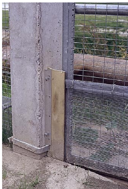
Detail hekwerk (zie ook fig. 7.36): werkpoort met gewapend betonnen dorpel en verticale flap bij het scharnier die zorgt voor afdichting voor kleine dieren
