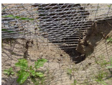
Door erosie is te zien dat er ook horizontaal een raster is ingegraven, hierdoor kunnen bijvoorbeeld dassen niet onder het raster door graven
