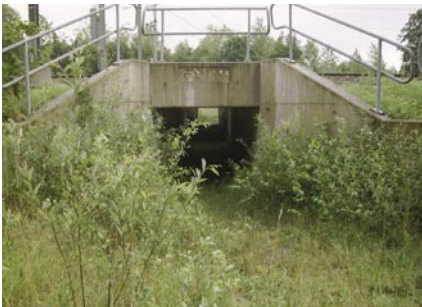
Voorbeeld van ruim gedimensioneerde kleine faunatunnel (kleine tot middelgrote dieren)
