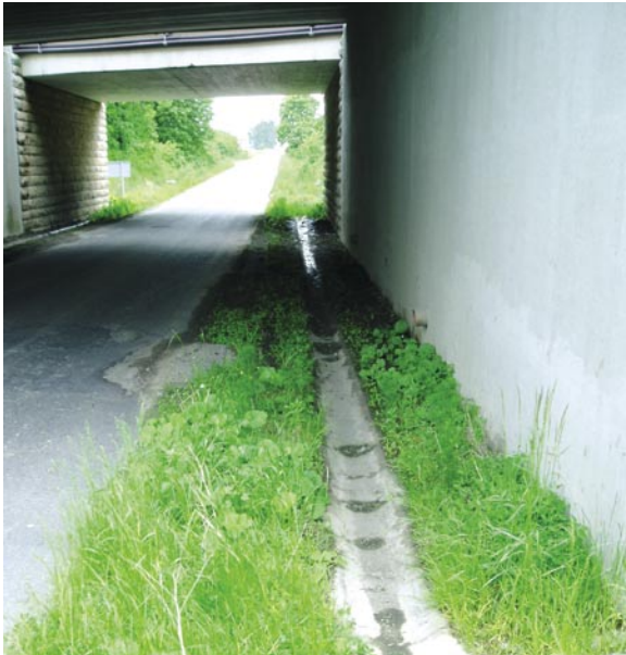
Tunnel met onverharde strook
