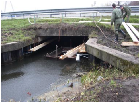
Aanbrengen van houten loopstroken
