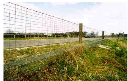
Kleinwild- en amfibieëraster; het fijnmazige raster wordt in verband met beschadiging bij onderhoud, het gemakkelijk inklimmen van dieren en de te grote maaswijdte voor jonge amfibieën bij voorkeur niet meer toegepast
