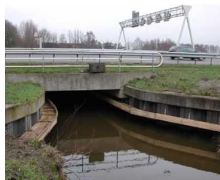
Houten loopstroken met opstaande rand onder bestaande brug aangebracht, verbonden met de oevers
