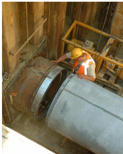
Aansluiting van betonnen faunatunnel (doorsnede inwendig 1000 mm) op de boorkop
