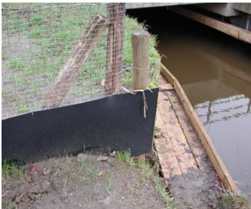
Let goed op aansluiting van de rasters en schermen op de loopstroken
