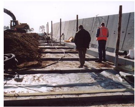
Bovenop het ecoduct zijn betonbalkjes gelijmd om water vast te houden, zodat vocht langer beschikbaar blijft voor de begroeiing (De Borkeld, A1)
