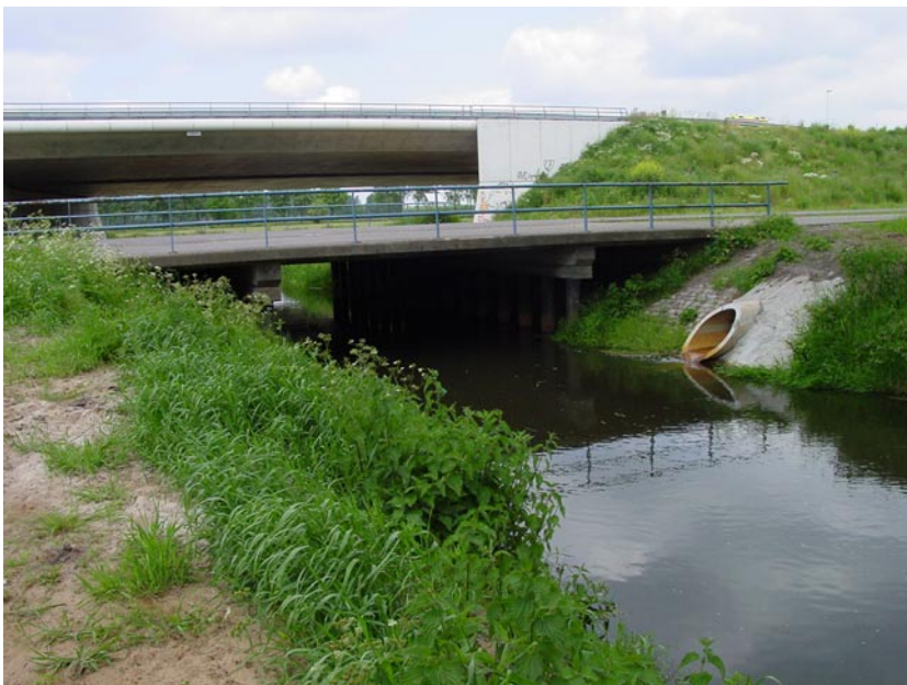
Voorbeeld van hoe het niet moet: ideale grote faunatunnel, maar parallelweg (voorgond) is niet ontsnipperd; gebiedsgerichte aanpak is nodig
