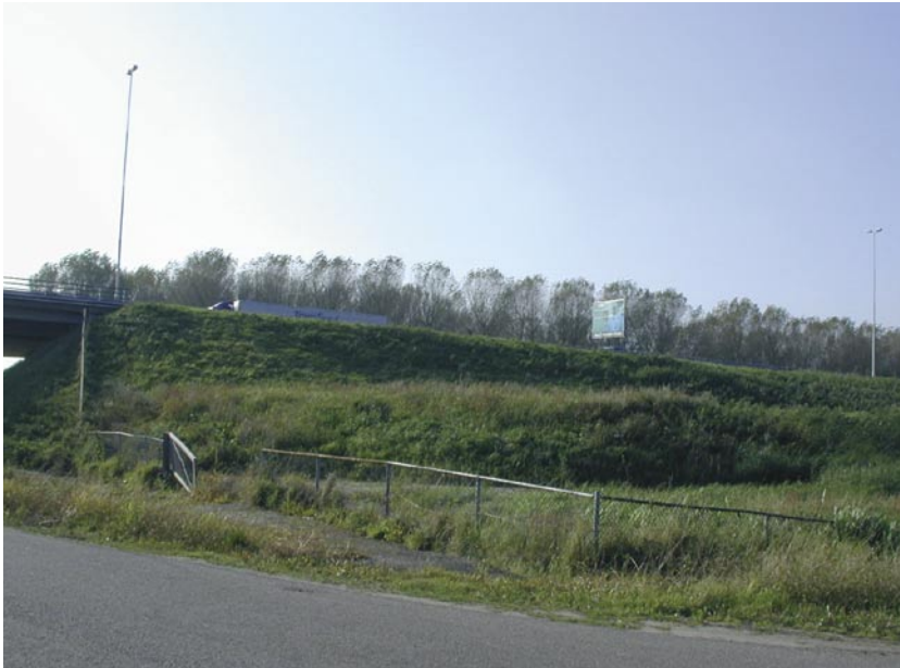
Bij inspectie moet worden bekeken of werkpoorten gesloten zijn en blijven
