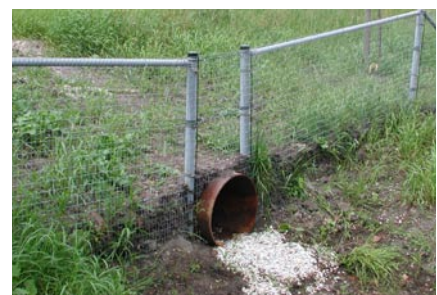
Dassentunnel met goede aansluiting op raster
