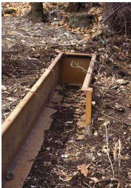
Aan het einde dient de geleidewand teruggebogen te worden zodat dieren die de wand volgen niet op dat punt alsnog op de weg terechtkomen
