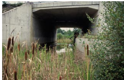
Met een perronwand is een onverharde strook onder de brug gemaakt
