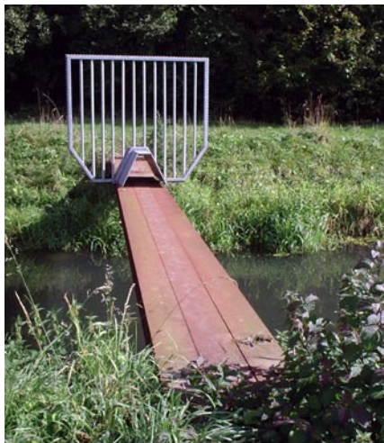
Oversteek sloot met rooster om passage van mensen te voorkomen
