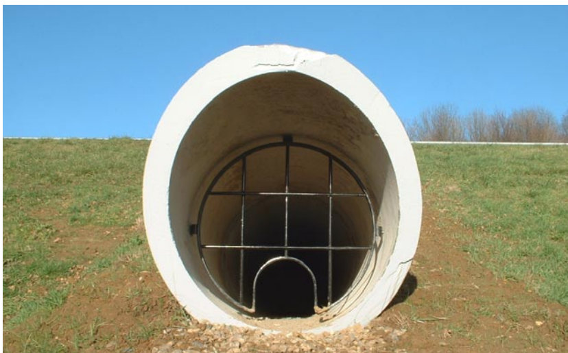
Kleine faunatunnel met rooster om inloop van mensen te voorkomen; het raster is later geplaatst
