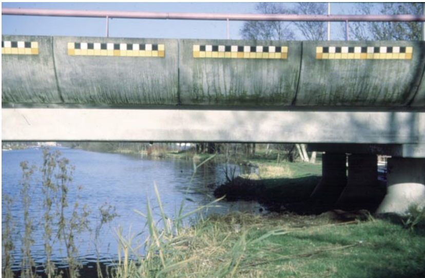
Doorlopende oever onder brug
