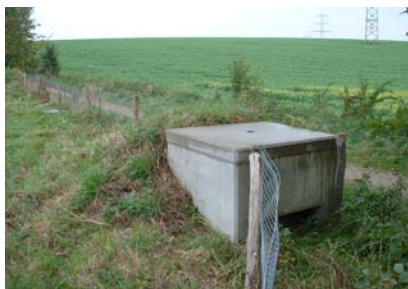
Ingang dassentunnel waarbij de afsluiting van de toelooptunnel tevens als insprong dienst doet (zie ook fig. 7.21 en 7.22)
