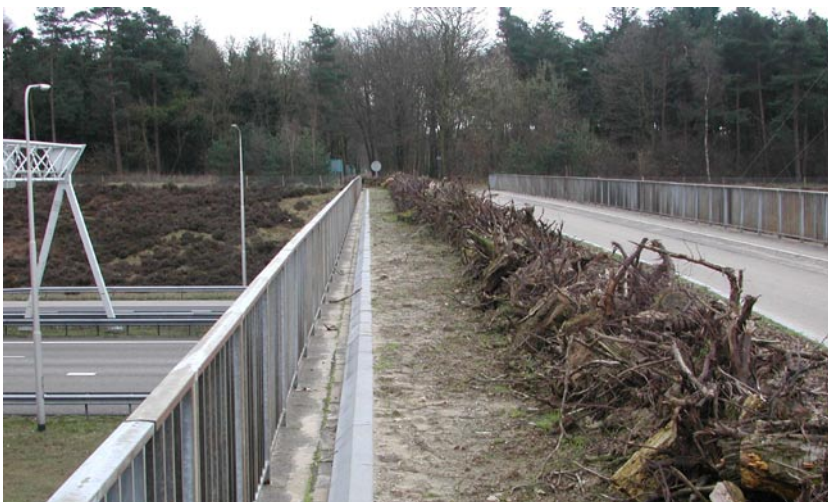
Aangepast viaduct met loopstrook en stobben, Wallenburg, A28 Utrecht
