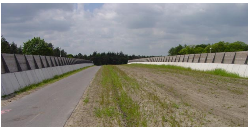
Ecoduct met medegebruik door fietsers (Slabroek)
