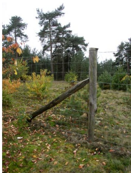
Detail ursusraster met palen van robiniahout
