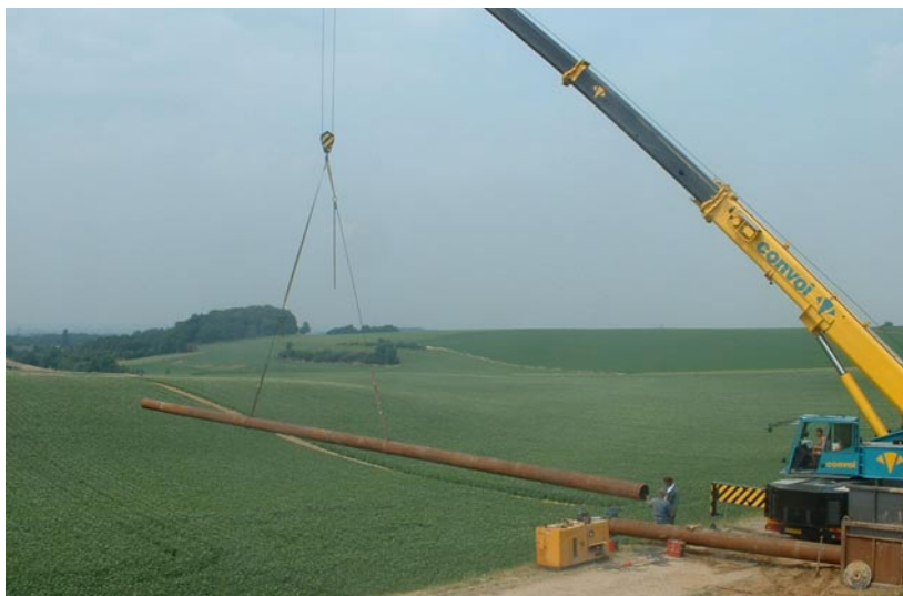
De stalen buis wordt voor het boorgat gesteld en daarna door het boorgat getrokken (op deze locatie was voldoende ruimte)
