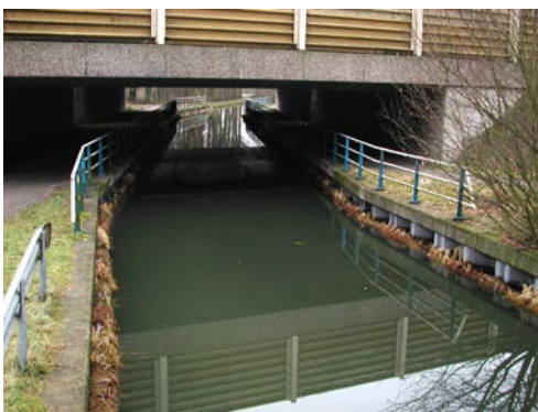
In het water is langs de oever een florarol aangebracht; links onbegroeid, rechts met ontwikkelde oeverbegroeiing. Als deze rol aansluit op het maaiveld van de oever kan deze voorziening voor een aantal kleine diersoorten ook als faunapassage dienen.
