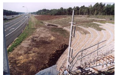
Talud opgebouwd met schanskorven
