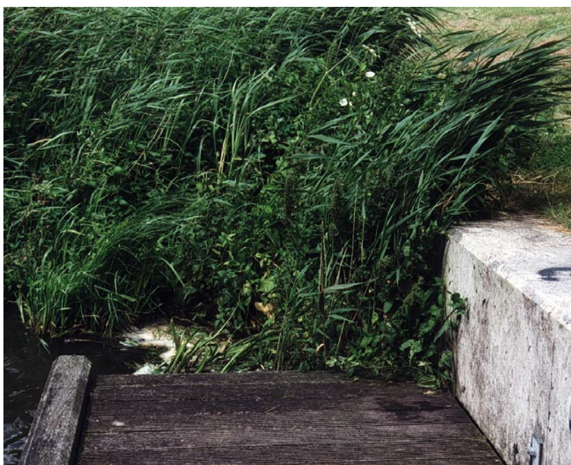
Faunalooptroken kunnen als kluunstroom gebruikt worden. Zorg daarom in schaatsgebieden voor afstemming van de vereisten voor beide functies. In bovenstaande situatie ontbreekt voor dieren de aansluiting op de oever
