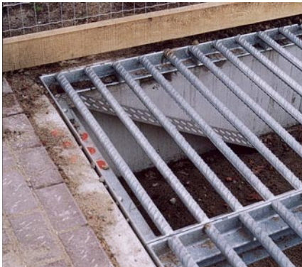
Metalen strip in wildroosterbak als uitklimvoorziening voor kleine dieren
