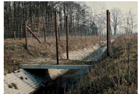
Betonnen loopplank over sloot als aanvullende voorziening bij een dassentunnel
