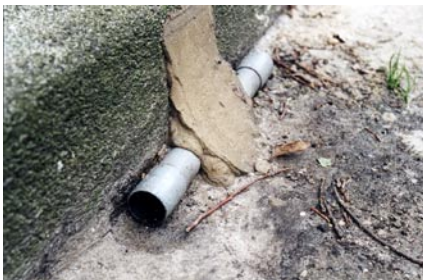
Op een viaduct moet een sporenbuisje voor kleine zoogdieren vastgezet worden, bijvoorbeeld met cement, zodat het niet weggehaald kan worden
