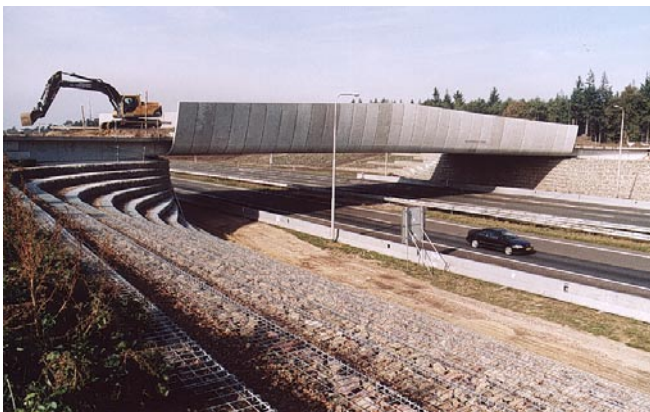
Aanleg van ecoduct de Borkeld (A1), onderste foto: het met schanskorven opgebouwde talud
