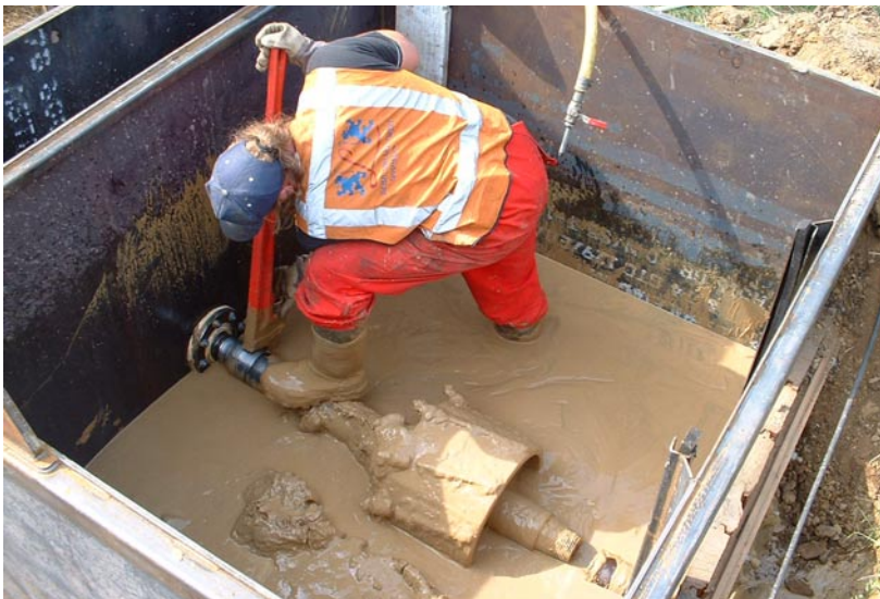
Het ontkoppelen van de boorkop (het boorgat is dan gevuld met bentoniet)
