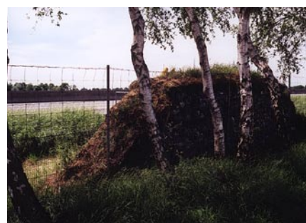
Mogelijk te steile inspringvoorziening
