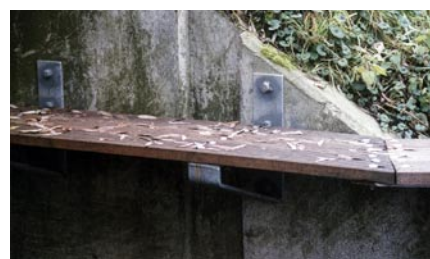
Een degelijke bevestiging van de loopplank bevordert het duurzaam functioneren ervan als faunapassage
