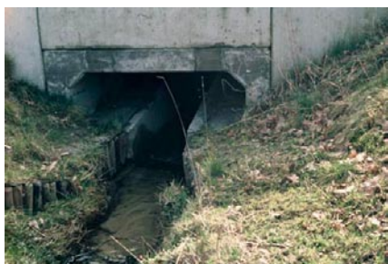
Ecoduker met aan beide zijden een loopstrook waarin grond is aangebracht
