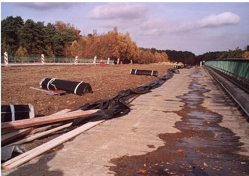
Breed viaduct wordt omgebouwd tot eco-duct met een fietspad aan beide zijden (België)
