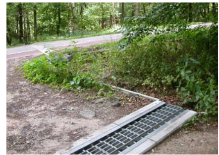
Amfibieënroostertunnel onder dwarsweg
