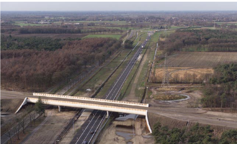
Aanleg ecoduct Slabroek (A50)
