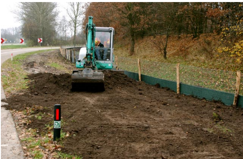
Aanleg rasters en amfibieschermen
