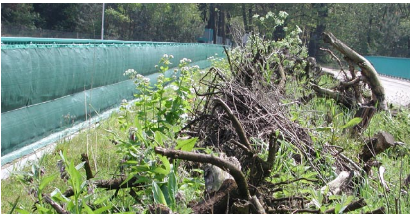
Aangepast viaduct: onverharde strook met stobben, daartussen spontane vegetatieontwikkeling (Wallenburg, Utrecht)
