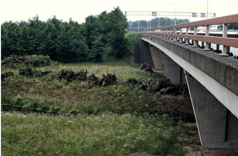
Geleiding naar de onderdoorgang kan bijvoorbeeld met stobbenwallen en een watergang
