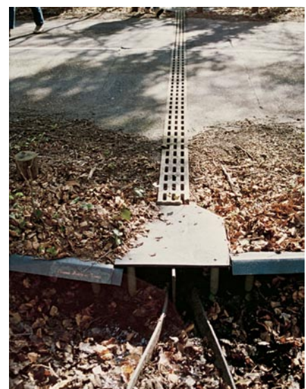
Voor amfibieën is extra geleiding naar de tunnelingang belangrijk (twee deels ingegraven kunststof platen)
