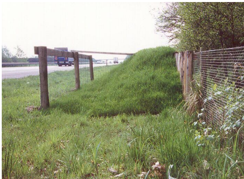
Inspringvoorziening met (links) kort geleidend raster en dwarsraster
