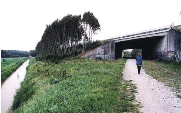
Viaduct met medegebruik
