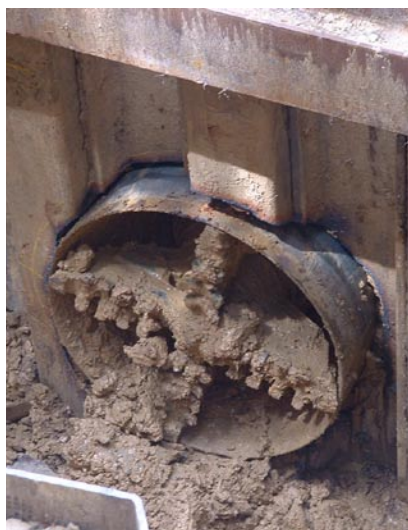
Boorkop in ontvangstop van boormethode Open Front Techniek (Rijksweg 79)
