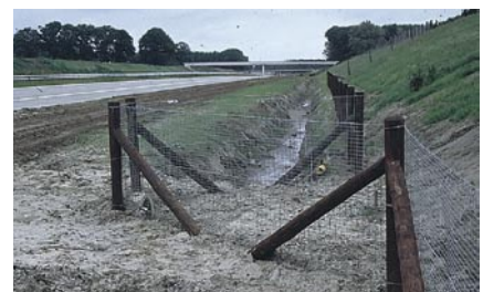
Raster sluit aan op ingang dassentunnel
