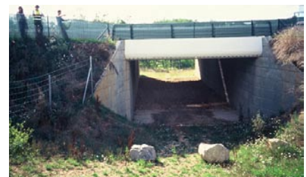
Faunatunnel voor middelgrote dieren (ree), de grote stenen dienen om ongewenst medegebruik tegen te gaan
