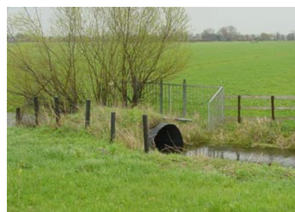
Een dam met duiker in de sloot geeft een natuurlijker aansluiting dan een betonnen loopplank
