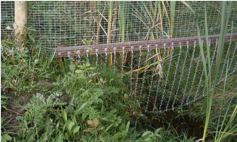
Raster loopt door over sloot. De kettingen voorkomen passage langs de sloot
