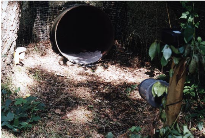
Infraroodvideocamera (onder) en infraroodschijnwerper aan paaltje voor ingang faunabuis, links aan boom een infrarooddetector waarmee de videocamera aangestuurd wordt bij passage van een dier
