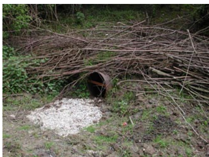
Dassentunnel met grindkoffer
