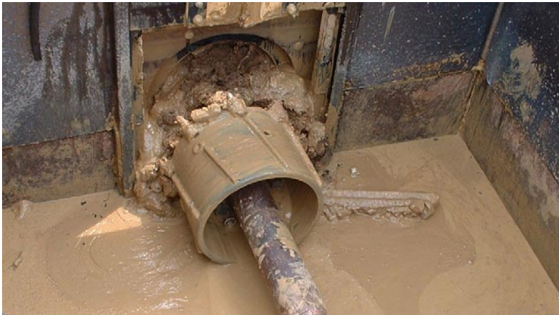
Boorkop bij begin van de boring
