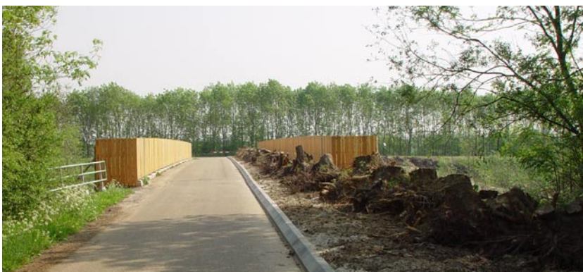
Aangepast viaduct: onverharde strook met boomstobben en houten schermen tegen geluids- en lichtinvloeden (Mienscheer, Groningen)
