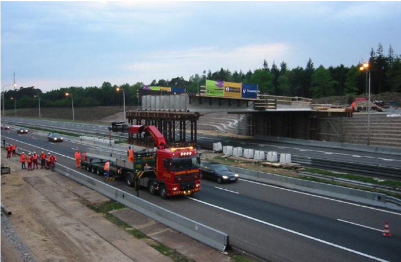
Aanleg ecoduct over een bestaande weg (A1 - de Borkeld)
