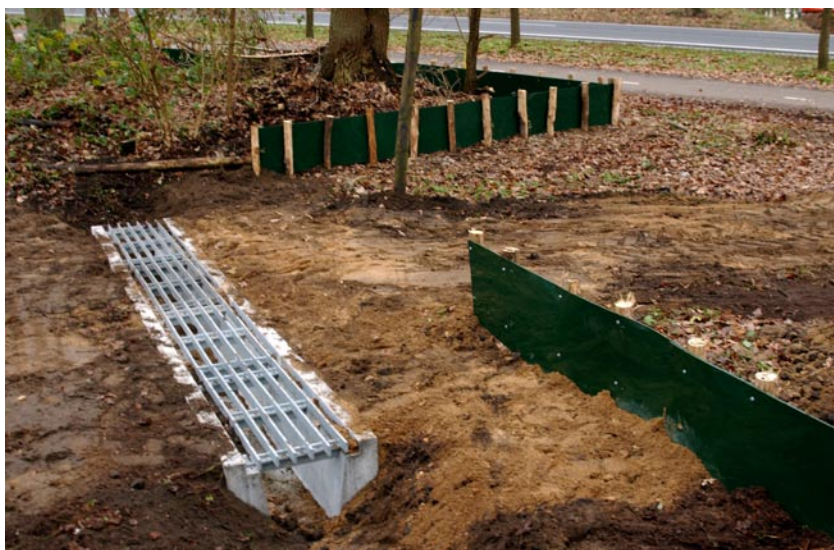
Aanleg roostertunnel in een zijweg
