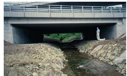
Een waterloop door de tunnel zorgt voor extra geleiding en vergroot het aantal soorten dat de tunnel kan gebruiken
