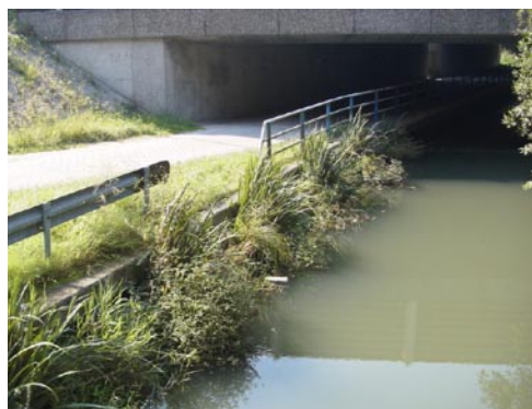
In het water is langs de oever een florarol aangebracht; links onbegroeid, rechts met ontwikkelde oeverbegroeiing. Als deze rol aansluit op het maaiveld van de oever kan deze voorziening voor een aantal kleine diersoorten ook als faunapassage dienen.
