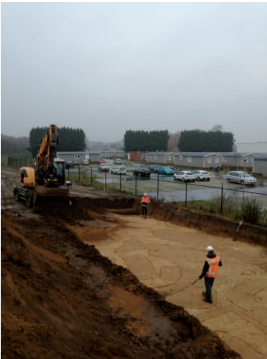
Afb. 2.5 Aanleg van werkput 1, foto richting het noordoosten.
