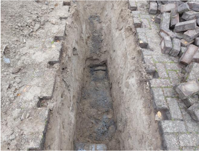
F01: Sleuf tbv onderzoek voegenkit riolering
