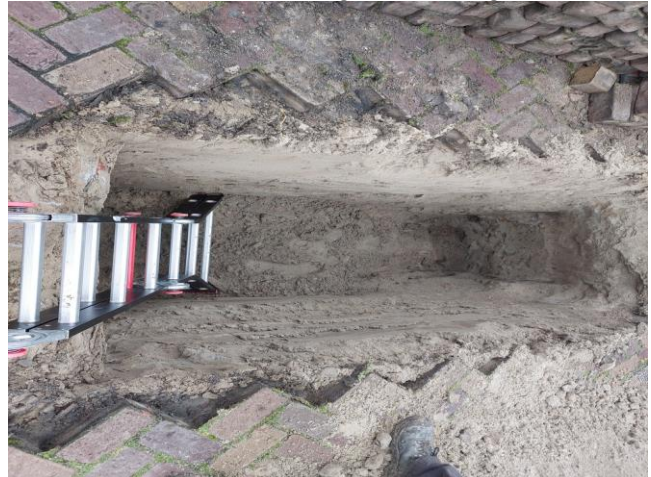
F02: Sleuf tbv onderzoek voegenkit riolering
