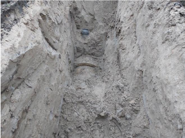
F01: Sleuf tbv onderzoek voegenkit riolering
