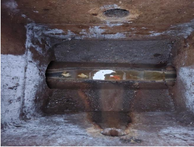
F07: inspectieputten (geen kit aanwezig)
