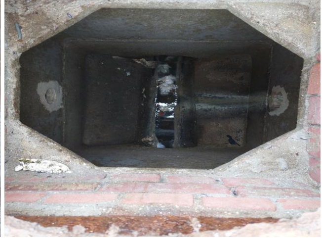
F08: inspectieputten (geen kit aanwezig)
