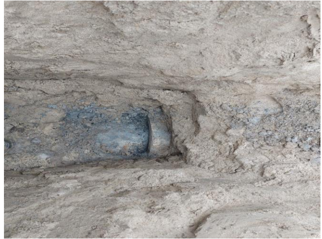
F02: Sleuf tbv onderzoek voegenkit riolering
