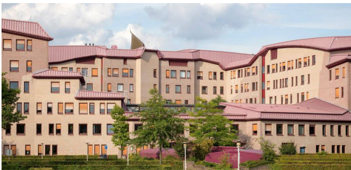
organisch vormgegeven trapsgewijs oplopende gevel in baksteen
