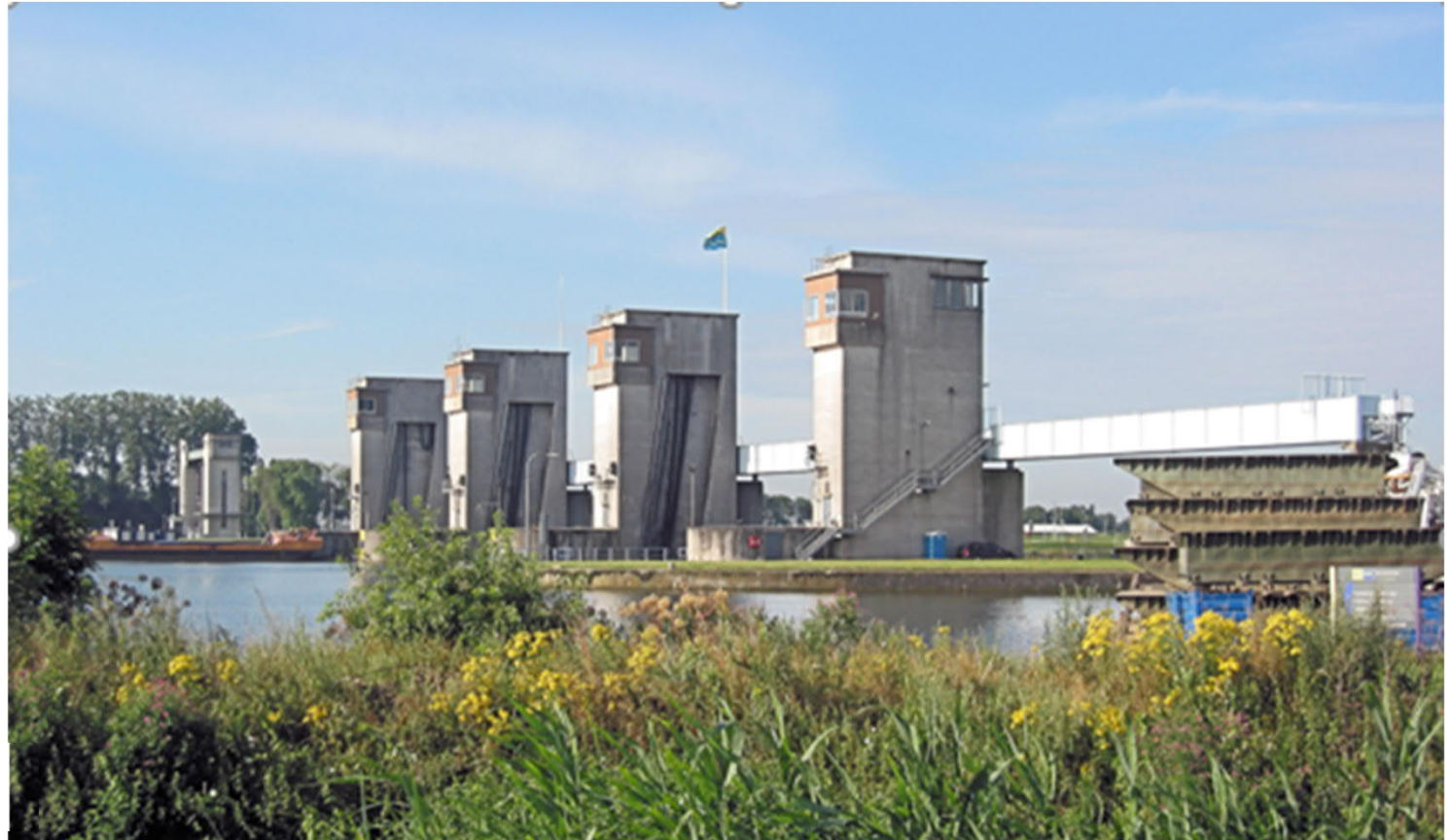
Stuw- en sluiscomplex Lith
