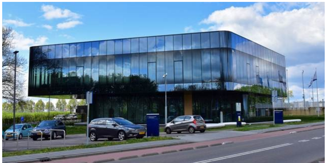
Figuur 2: Bediencentrale Maasbracht
