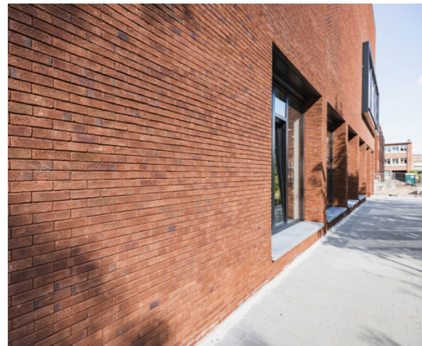
VAN DER SANDEN METSELWERK MILANO 0059A0 VERZAAGD IN STEENSTRIPS
