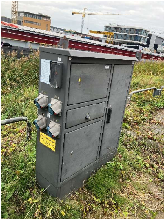
Gemeentekade Biesboschhaven Zuid thv huisnummer 10 Nieuwe kast aansluitingen 1x16a, 3x32a en 2x63a
