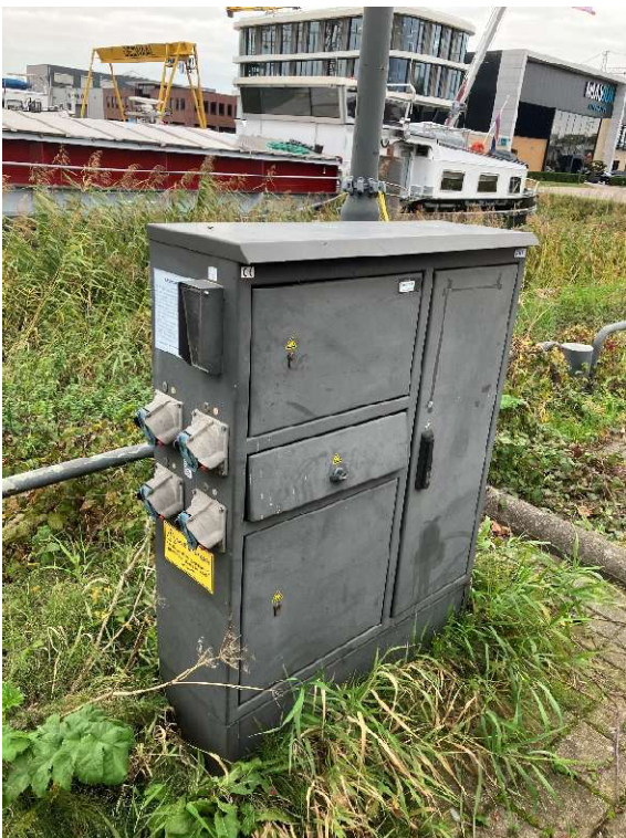
Gemeentekade Biesboschhaven Zuid thv huisnummer 8 Nieuwe kast met aansluitingen 1x16a, 3x32a en 2x63a
