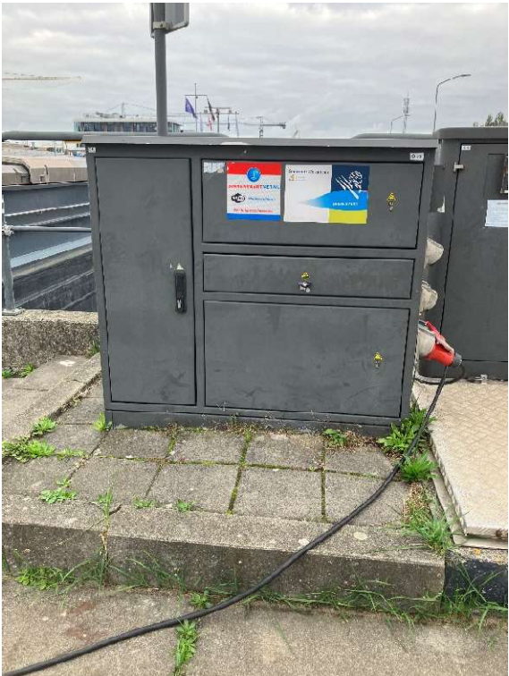
Gemeentekade Biesboschhaven Zuid thv huisnummer 12 Nieuwe kast aansluitingen 1x16a, 3x32a en 2x63a + watervoorziening
