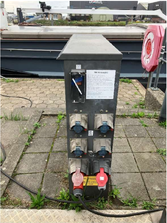
Gemeentekade Biesboschhaven Zuid thv huisnummer 12 Nieuwe kast aansluitingen 1x16a, 3x32a en 2x63a + watervoorziening
