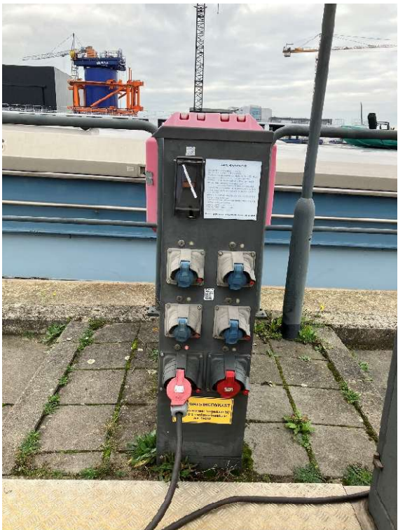
Gemeentekade Biesboschhaven Zuid thv huisnummer 20 Nieuwe kast aansluitingen 1x16a, 3x32a en 2x63a + watervoorziening
