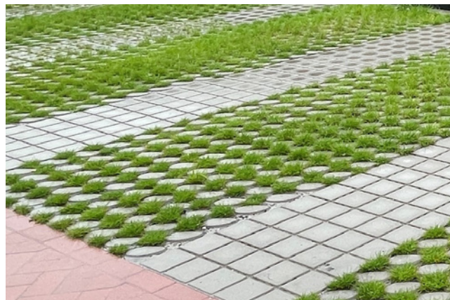
Parkeeroplossing met een gradiënt van grasbetonstenen
