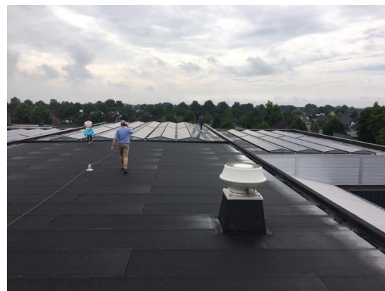
4. Op voorliggende dak nog 16 panelen te plaatsen
