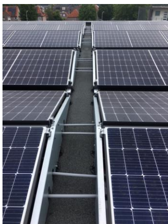
5. Kabels in buisjes tussen vlakken
