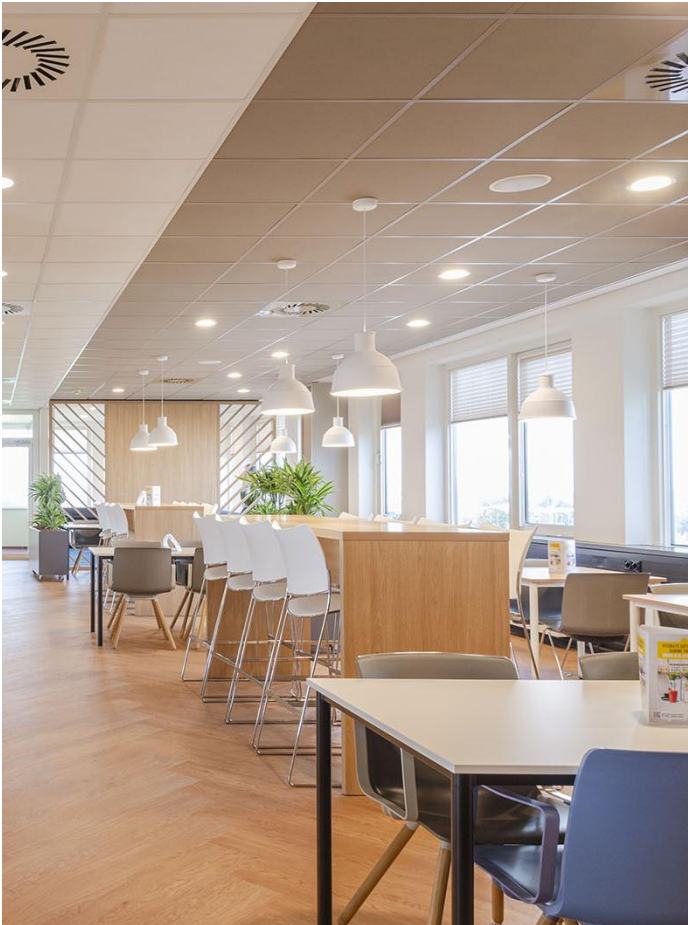
Afbeelding 3: gekleurd systeemplafond
