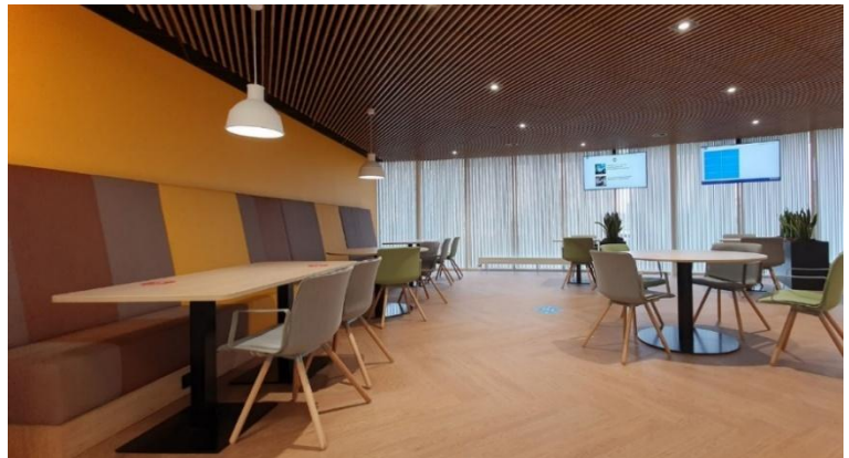
Afbeelding 5: Overzichtsfoto houten systeemplafond
