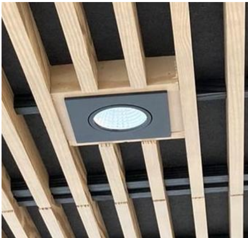
Afbeelding 4: Detail houten plafondpaneel
