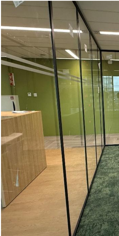
Afbeelding 14: Glazen systeemwand: type 4 enkelglas met doorloopbeveiliging
