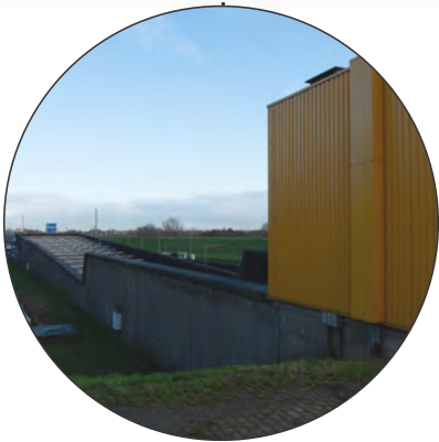
De kenmerkende tunneltoerit en het dienstgebouw passen niet bij elkaar.
