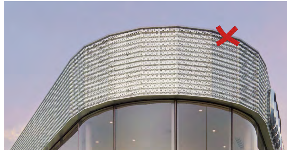
Figuur 22. Gevel met facetten.
