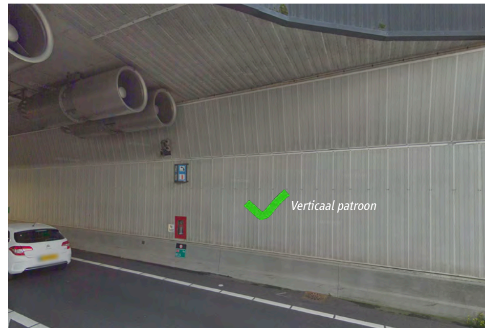
Figuur 60. Afwerking tunnelwanden Ketheltunnel.
