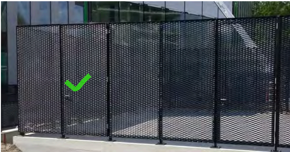
Figuur 30. Subtiële detaillering zorgt voor onopvallende deuren in strekmetaal.
