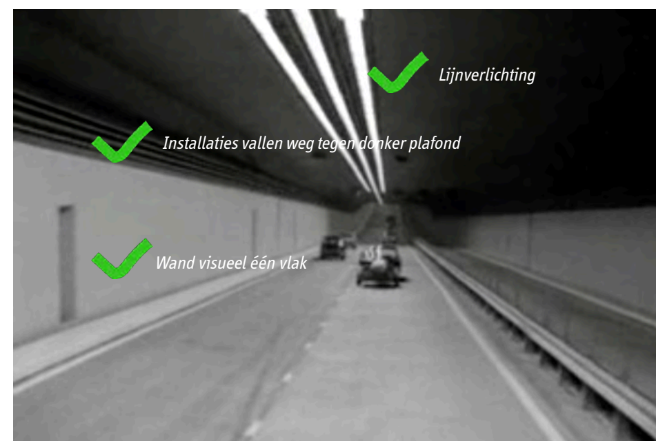
Figuur 56. Het oorspronkelijke ontwerp van de Eerste Heinenoordtunnel had een rustige en heldere vormgeving.
