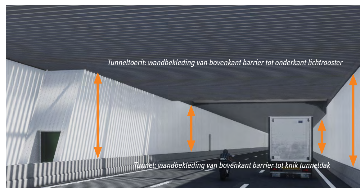
Figuur 58. Afwerkingsprincipe tunnelwanden.
