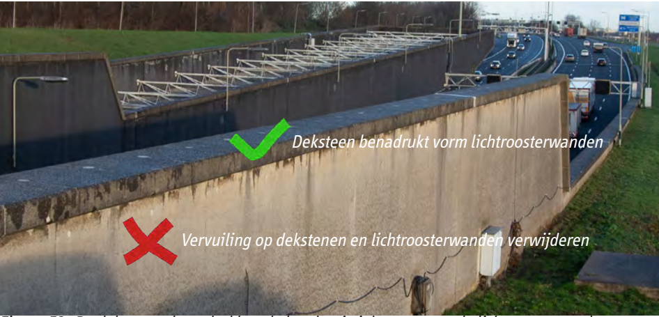
Figuur 53. De dekstenen benadrukken de karakteristieke vorm van de lichtroosterwanden.
