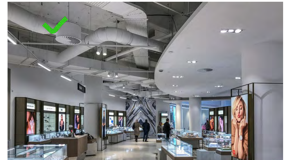
Figuur 39. Alle kabels, leidingen en installaties onder het plafond hebben eenzelfde kleur.
