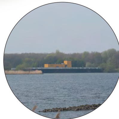
Damwand en inham onderbreken het natuurlijke landschap. Het dienstgebouw vormt een storend element.
