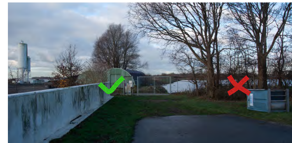
Figuur 13. Huidig hekwerk bouwdok voldoet als omheining voor PV panelen. Nieuwe hekwerken dienen vermeden te worden.
