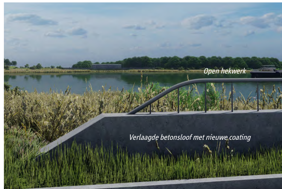
Figuur 47. Betonsloof en hekwerk met afgeschuinde beëindiging en afgeronde hoek.
