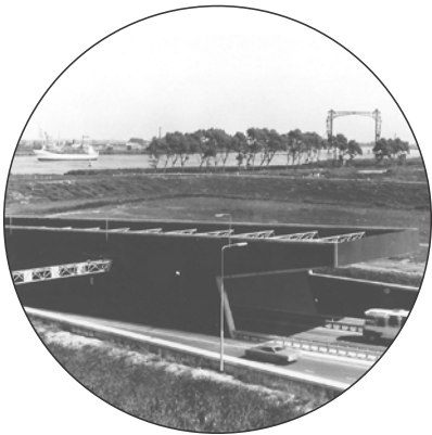
De kenmerkende en expressieve lichtrooster constructie is typerend voor de bouwtijd van de tunnel.
