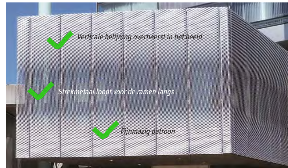
Figuur 24. Streckmetaal gevel voor glas, met verticale belijning en variërend patroon.
