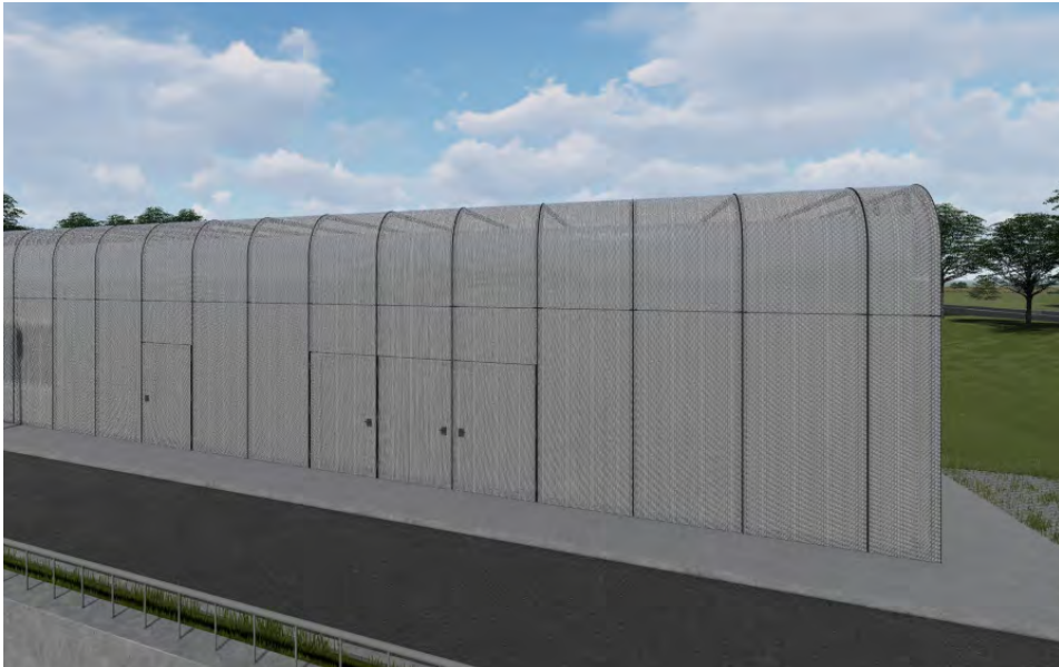
Figuur 29. Deuren zijn onopvallend verwerkt in de tweede huid.
