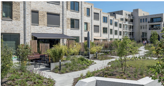
Afbeelding 23. De afmeting van de achtertuinen vormt een balans tussen privacy en openheid voor ontmoeting. Poortmeester, Delft
