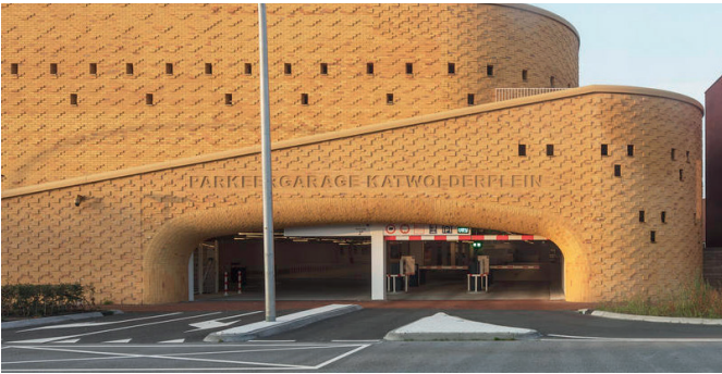
Afbeelding 13 b Parkeergarage Katwolderplein in Zwolle, met een zorgvuldig ontworpen in- en uitrit. Foto: Dok Architecten
