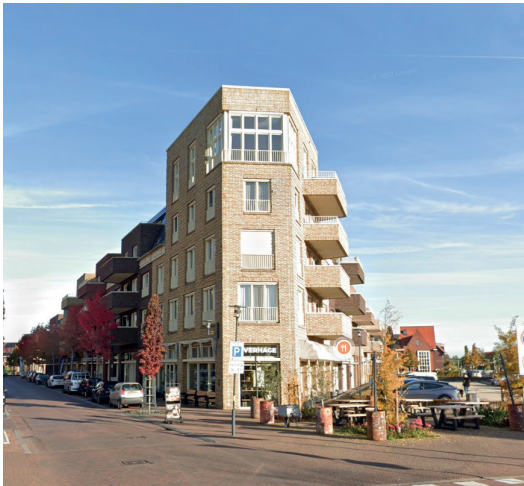
Afbeelding 16 De scherpe hoek is onderdeel van de architectuur, met goede leefruimtes ook in de hoek.
