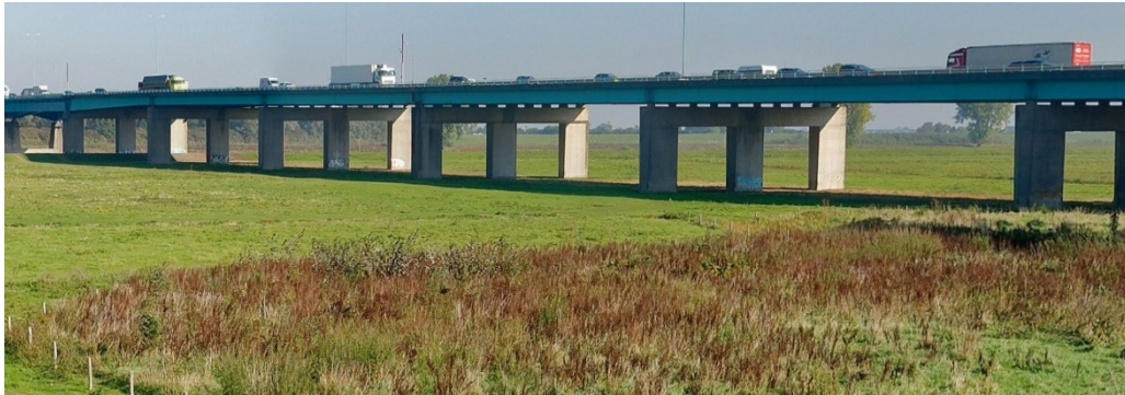
Figuur 6 Hagesteinsebrug aanbruggen
