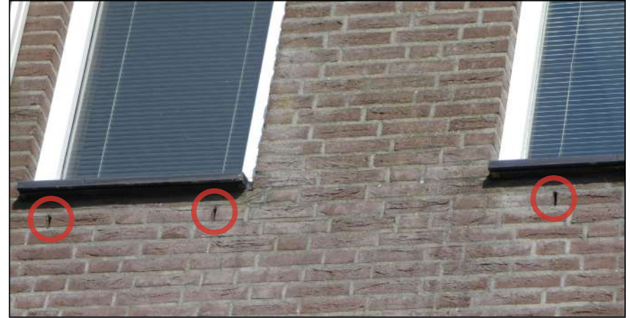
Figuur: close-up van de open stootvoegen in het gebouw aan de oostzijde van het plangebied. Vleermuizen kunnen open stootvoegen gebruiken om toegang te krijgen tot de spouwmuur en daar verblijven.
