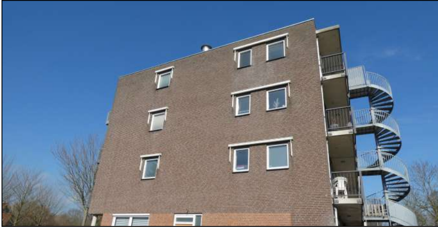
Figuur: het gebouw aan de oostzijde van het plangebied is geschikt als verblijfplaats voor vleermuizen, omdat het gebouw (vele) invliegopeningen heeft in de vorm van open stootvoegen.
