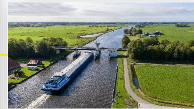
Nu in voorbereiding Brug Oude Schouw 11A-104-01
