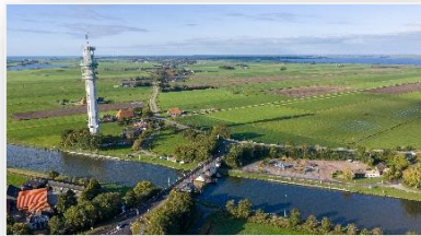
Nu in voorbereiding Brug Spannengurg 15F-102-01
