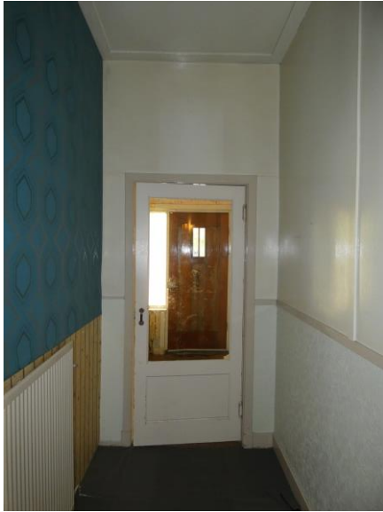
6.4.7. De gang uit 1939 met de originele klapdeur naar de vestibule. Rechts nog de originele wandafwerking uit 1939 met lambrisering. Links is de wandafwerking onder het behang verdwenen.
