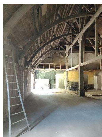
6.2.2 In beiden zijbeuken van de stal zijn omstreeks 1939 schenkelspanten toegevoegd. Hiermee ontstond er meer vrije hoogte voor de werktuigen.
