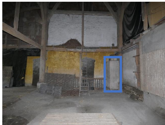
6.4.42 Voorheen zat er tussen de brandmuur en de tasruimte een gang. In 1939 is deze scheidingswand verwijderd, waardoor de brandmuur vanuit de stal zichtbaar is geworden. Het bovendeel van de brandmuur is met kalkpleister wit gemaakt. De okergele tinten onder zijn waarschijnlijk lijnresten van het behang wat hierop zat. Het kan ook leemstuc zijn.
