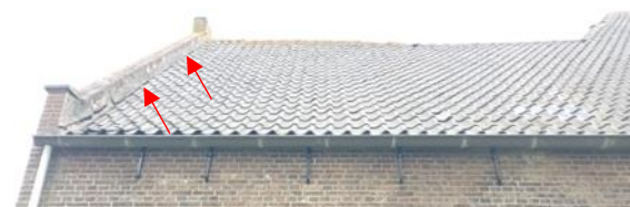
6.3.45. De aansluiting van de tuitgevel van het staart-eind met het dak d.m.v. cementspecie.
