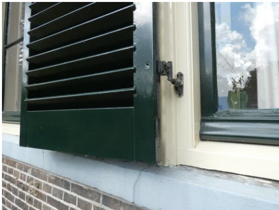
6.3.9. Alle schuifvenster zijn aan de buitenzijde voorzien van persiennes. Deze zijn echter allen vernieuwd en hebben nu modern hang-en-sluitwerk met kruiskopschroeven. Waarschijnlijk gelijk met de kozijnen en vensters die naar oud voorbeeld zijn nagemaakt. Vermoedelijk is dit in 1987 gebeurd toen ook de dakpannen zijn vervangen.
