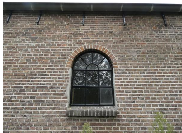
6.3.15. Het bovenlicht van de dichtgezette deur is min of meer behouden gebleven als venster voor de badkamer. Het kozijn en venster zijn wel vernieuwd. In de muur is verder een vrij moderne schroefverankering waar te nemen van de hoekschouw in de nieuwe jaren 50 keuken die toen aan de linker kant van de brandmuur is gerealiseerd. (Rode pijl.)
