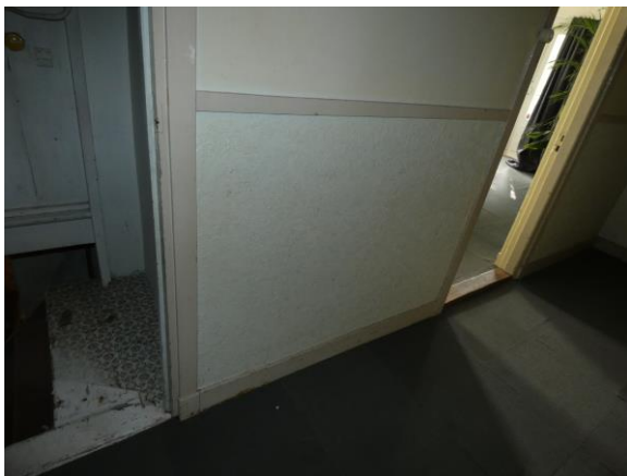
6.4.7. De gang uit 1939 met de originele klapdeur naar de vestibule. Rechts nog de originele wandafwerking uit 1939 met lambrisering. Links is de wandafwerking onder het behang verdwenen.
