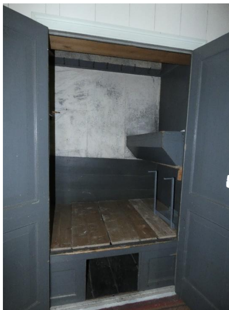
6.4.36. Binnenzijde van de bestede. Te zien is een gaaf bewaard voorbeeld uit 1857. In de houten bak rechts tegen de scheiding zit een kribbe. Hier kon een van de kleine kinderen slapen.
