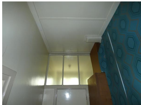
6.4.10. Aan het einde van de gang bevindt zich tegen de linker zijgevel een badkamer. Deze badkamer heeft aan de gangzijde een bovenlicht met gewolkt glas. Het plafond in de gang lijkt authentiek uit 1939, maar bestaat wel uit ongestuukte boardplaten.
