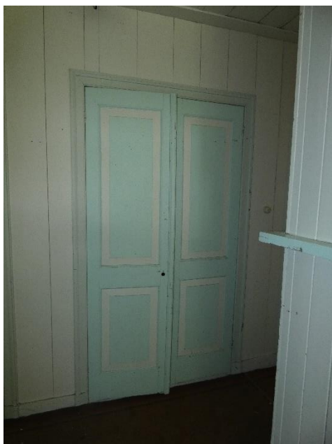
6.4.35. De bedstedewand op de verdieping is grotendeels behouden gebleven. Op de foto twee van paneeldeuren uit de eerste bouwfase.
