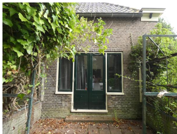
6.3.13. Het melkmeisje met de openslaande tuindeuren dat waarschijnlijk kort na de Tweede Wereldoorlog in de gevel is gezet.
