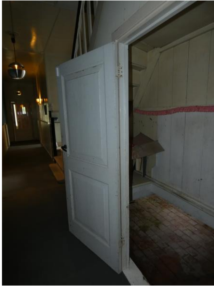
6.4.1. De entree van de kelder met een authentieke 19-eeuwse deur met bossingpanelen en de houten schotwand.
