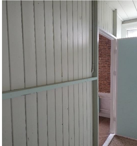
6.4.38. Op de middelste zolder zijn eind jaren 40 twee slaapkamers getimmerd. Links de schrootjeswand, rechts de Bruynzeel deuren die voorzien zijn van bakelieten deurklinken.
