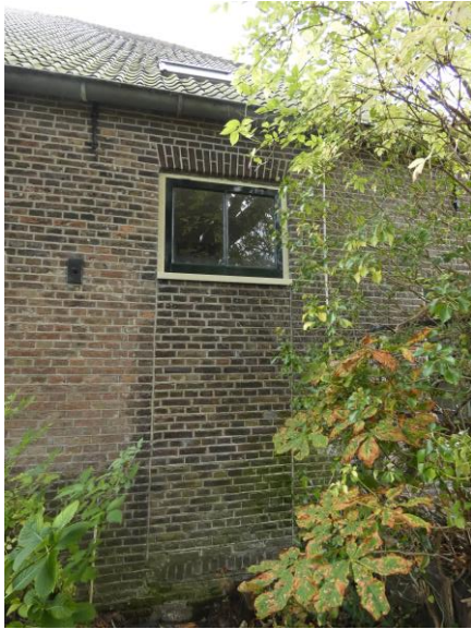
6.3.14. De dichtgezette toegangsdeur naar de voormalige keuken.
