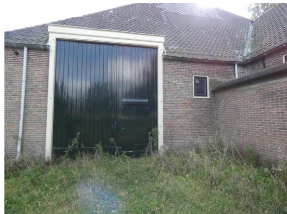
6.3.25. De darsdeuren zijn een keer verhoogd en steken nu boven de dakrand uit. Waarschijnlijk gelijktijdig veranderd bij het plaatsen van de schenkelspanten.
