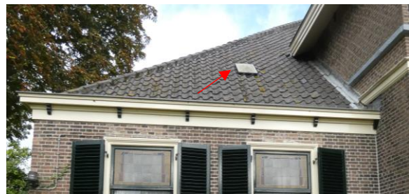
6.3.41. De aansluiting van de voorgevel met de zijgevel. Waarin de sierlijke houten bakgoot overgaat in een eenvoudige mastgoot. Alle gootconstructies zijn nog authentiek. De hemelwaterafvoeren zijn niet meer origineel en vervangen door regenpijpen van grijs pvc.
