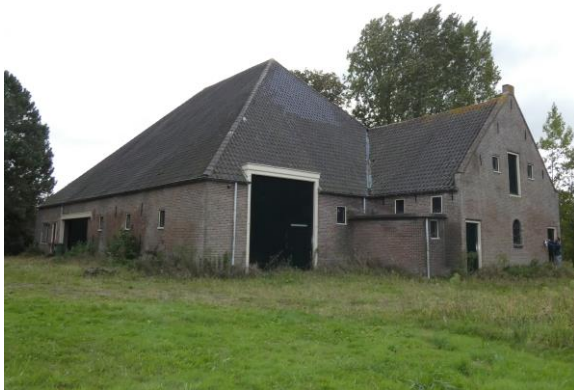
6.3.24. Overzicht van de achtergevel met aan de linkerzijde de verhoogde darsdeuren en aan de rechterzijde het verlengde staartstuk.
