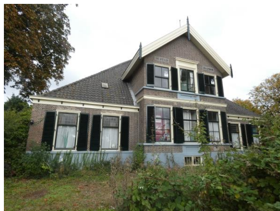
6.3.2. De voorgevel is symmetrisch van opzet en heeft in het midden een topgevel. Het risalerende middendeel met de topgevel verdeelt de voorgevel in drie traveeën.
