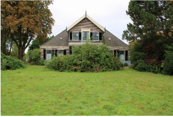
6.5.1. Symmetrische voorgevel met kenmerkende risaliet. De wildgroei centraal voor op de foto is later ontstaan en past niet bij de oorspronkelijke open voortuin.
