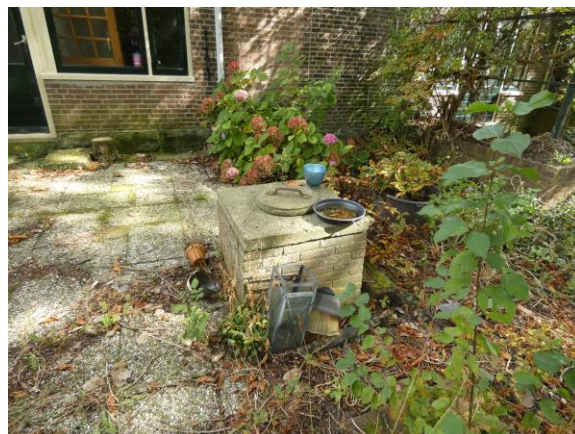
6.3.23. Ter hoogte van de keuken is er nog een oude regenwaterput. De bovenzijde is een keer vernieuwd.
