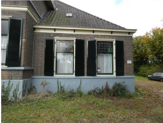
6.3.7. De rechter travee met gemoderniseerde schuifvensters en glas-in-lood bovenlichten.
