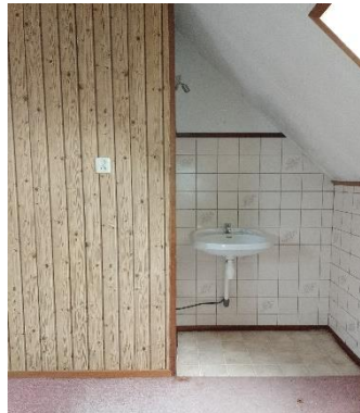
6.4.40. In beiden slaapkamers op de zolder linksboven zijn nisjes gemaakt. Deze nisjes zijn voorzien van omtegelde wastafels en net als de slaapkamer zelf vermoedelijk gerealiseerd in de jaren 80.
