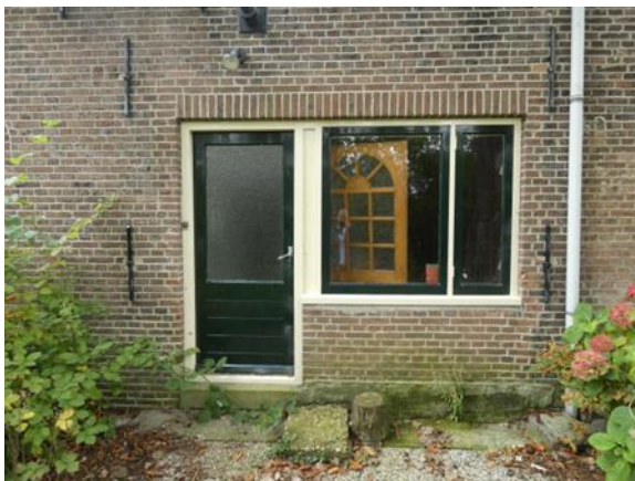
6.3.16. Het vlagkozijn met buitendeur en venster van de nieuwe jaren 50 keuken. Links en rechts van deze gevelopening zien we de dubbele verankering van de muurstijlen waar de schenkelspanten op rusten. Deze (aangepaste) constructie is dus ouder dan de keuken.
