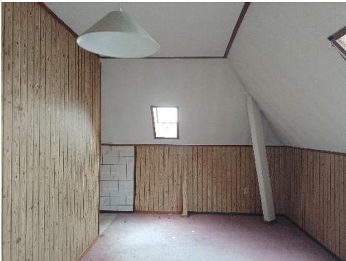
6.4.39. De buitenste zolder aan de linker zijde is in de jaren 80 van de vorige eeuw verbouwd tot twee slaapkamers. De houten schroten van de knieschotten en de betimmering van de binnenwanden waren een veelgebruikt interieurkenmerk uit die periode.
