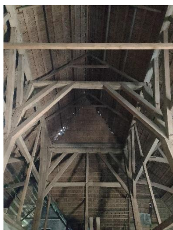
6.2.1 De draagconstructie uit de eerste bouwfase. Deze bestaat uit twee onderling gekoppelde vierkanten. De constructie is gemaakt van grenenhout.
