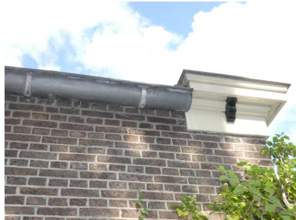
6.3.41. De aansluiting van de voorgevel met de zijgevel. Waarin de sierlijke houten bakgoot overgaat in een eenvoudige mastgoot. Alle gootconstructies zijn nog authentiek. De hemelwaterafvoeren zijn niet meer origineel en vervangen door regenpijpen van grijs pvc.
