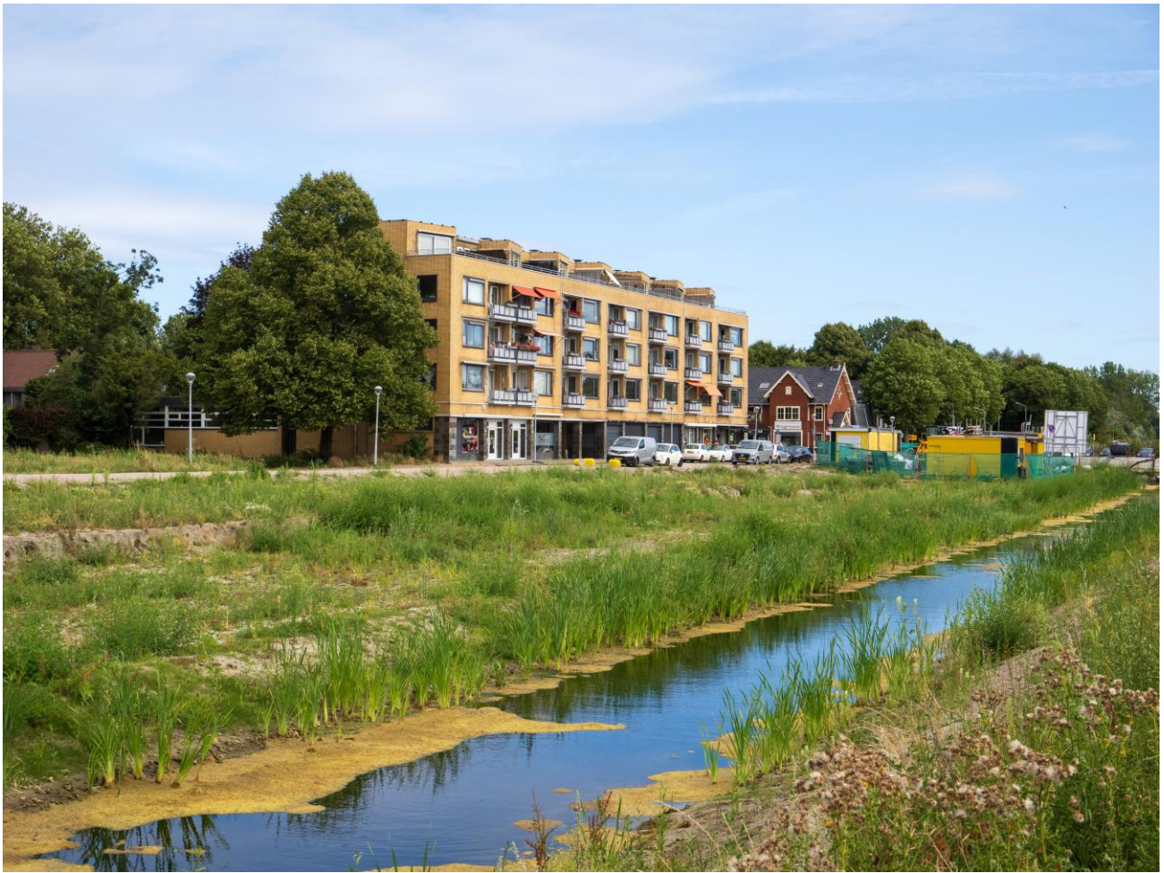
Moderne nieuwbouw: mix van eengezinswoningen en appartementen
