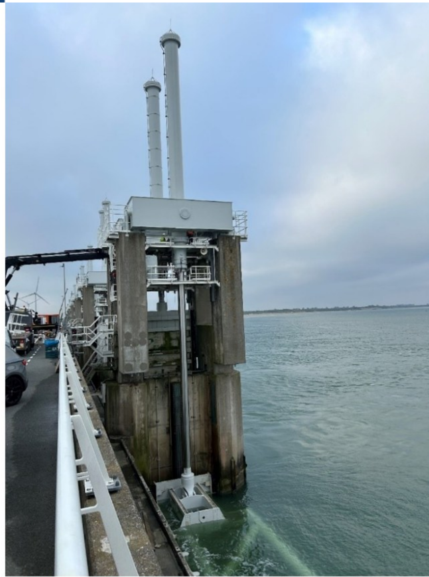
Figuur 2 Volledig uitgeschoven cilinder
