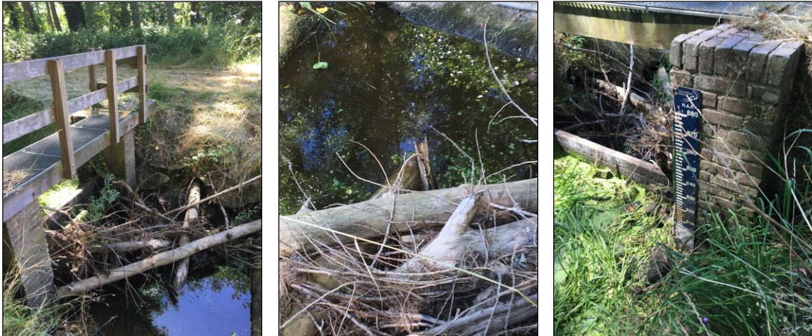
Figuur 13 Staat van stuw DO138-st2 in de Berkenloop voor uitmonding in de Groote Waterloop (juli 2018).
