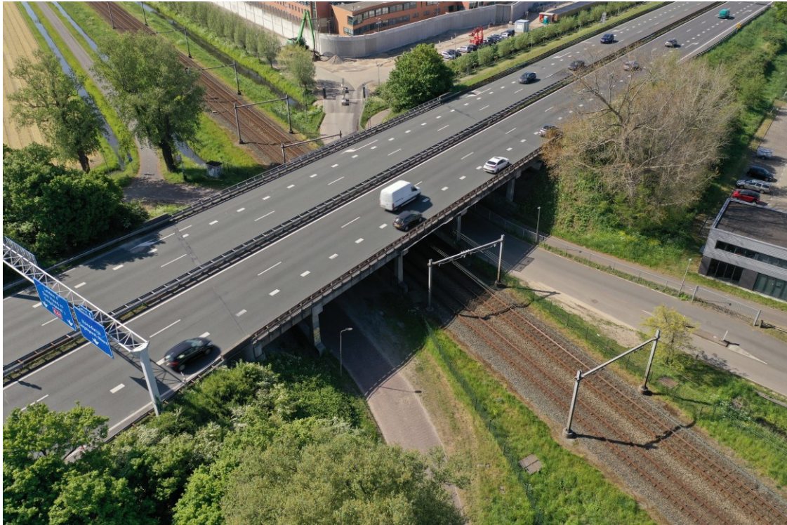
Foto 1 Spoorwegviaduct vanaf de noordoost zijde van het kunstwerk
