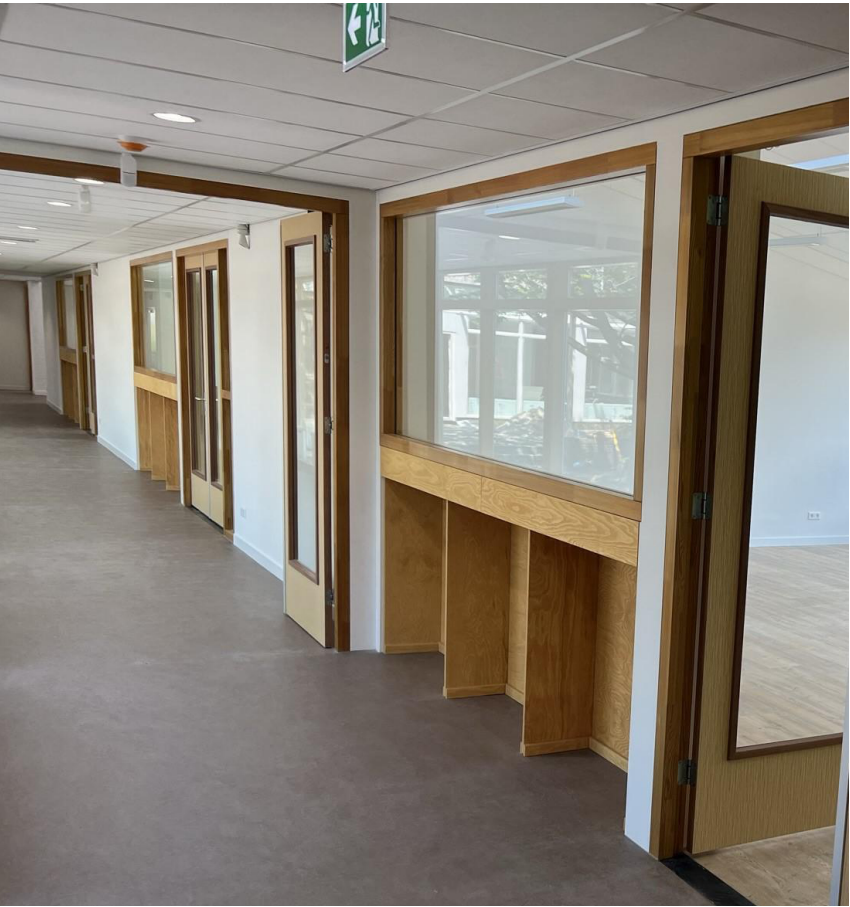
Principe opstelling garderobekasten onder raamkozijn (vrijstaand)
