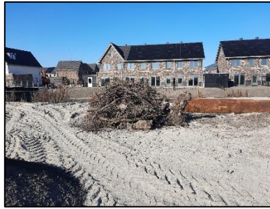
Figuur 4. Voorbelasting noordelijke deel van fase 4-5.
