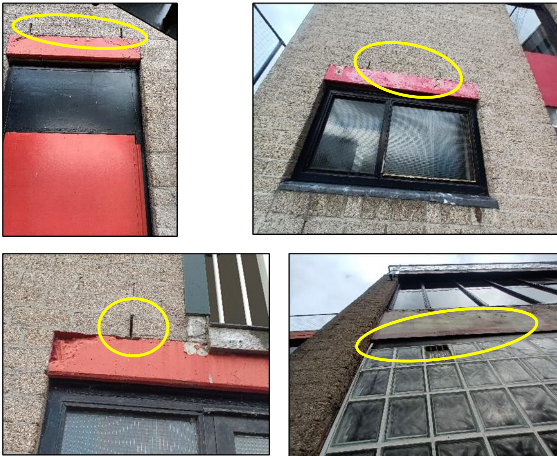
Figuur 5.1: Stootvoegen en wijkende gevelbetimmering in het gebouw van de korfbalvereniging.
