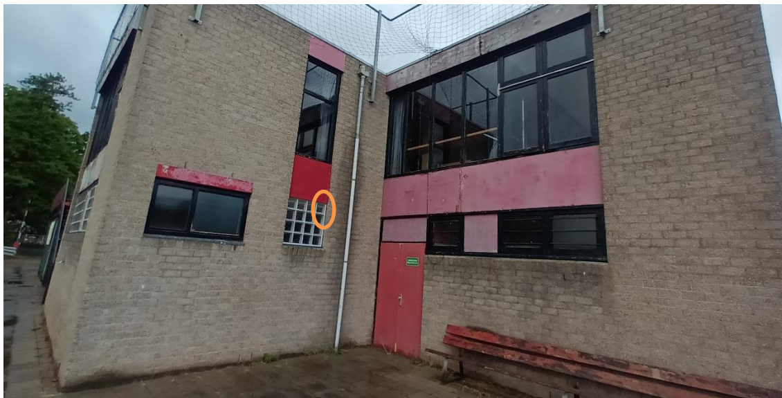
Foto 5: noordzijde van het korfbalgebouw met (oranje omcirkeld) de locatie van de verblijfplaats van Gewone dwergvleermuis (A&W, 2023)
