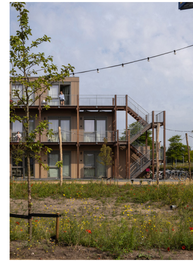
open galerij, deel van constructie
