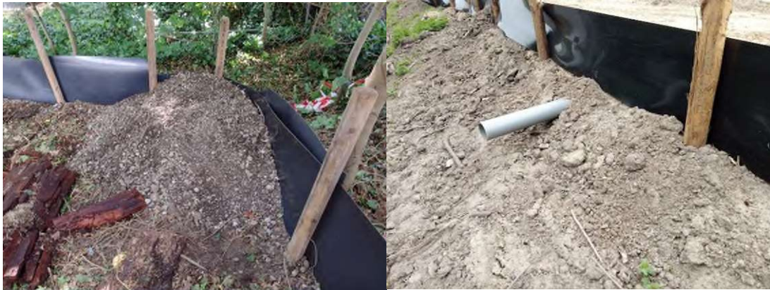
Figuur 4.2 Uittreed mogelijkheden voor reptielen en amfibieën langs het kerend scherm
