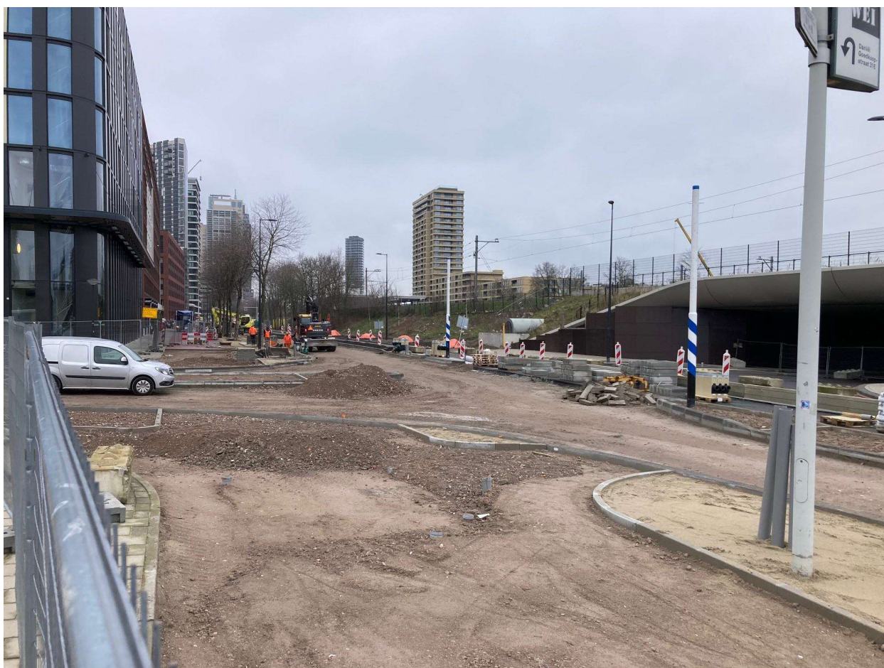
Figuur 2 uitvoering kruising Spaklerweg – Amstelstroomlaan januari '23
