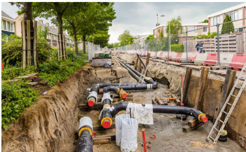
Figuur 2. De aanleg van een warmtenet door HVC in Gorinchem
