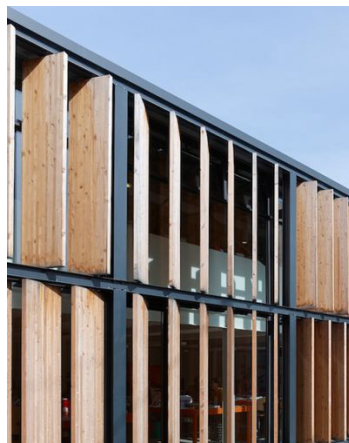
Dynamische gevels door gebruik van lamellen.
