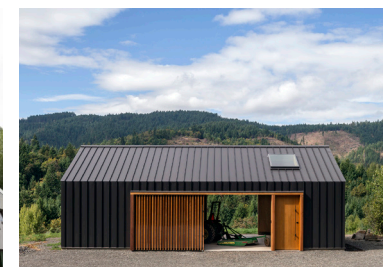
Schuur voor fietsenstalling met een eenvoudig volume en kap.
