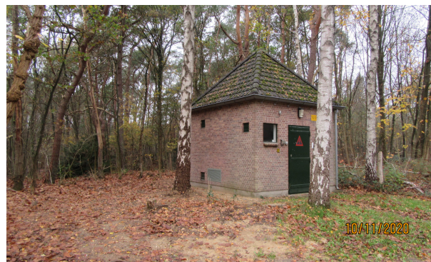
Zijaanzicht bouwwerk links
