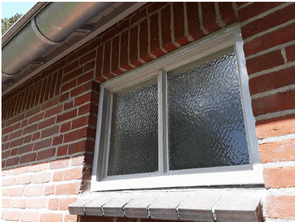
40B1 8P2, gevelkozijnen: recent beglazing vervangen en geschilderd (zie deskresearch)
