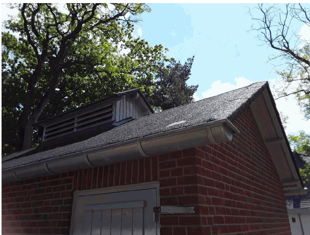
40B1 8P2, dakbedekking niet asbesthoudend (zie deskresearch)
