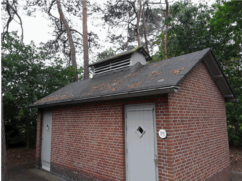
40B18P1, geen asbestverdachte materialen aangetroffen (dak en gevel reeds onderzocht/bemonsterd, zie deskresearch)
