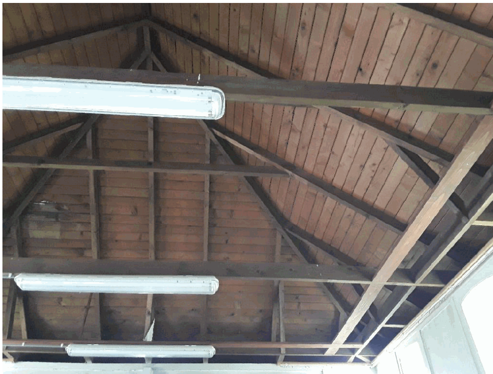
40B18F dakbeschot van hout, niet asbestverdacht
