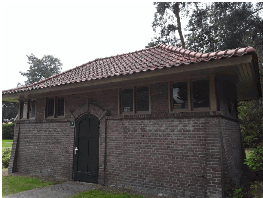
40B18F aangezicht gebouw
