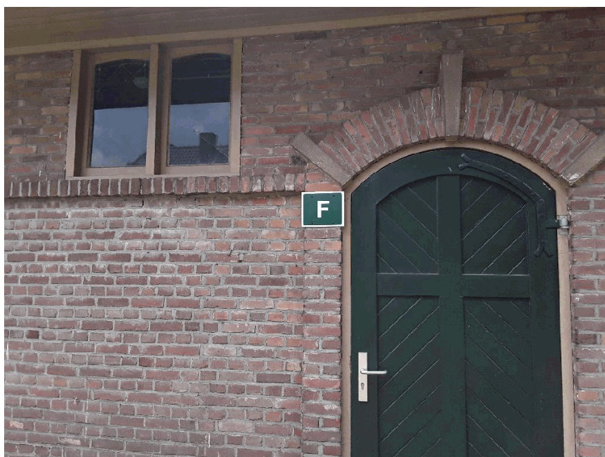
40B18F aangezicht gebouw
