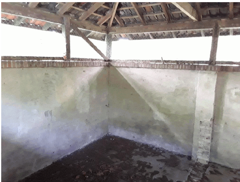
40B18E8, geen asbestverdachte materialen aangetroffen
