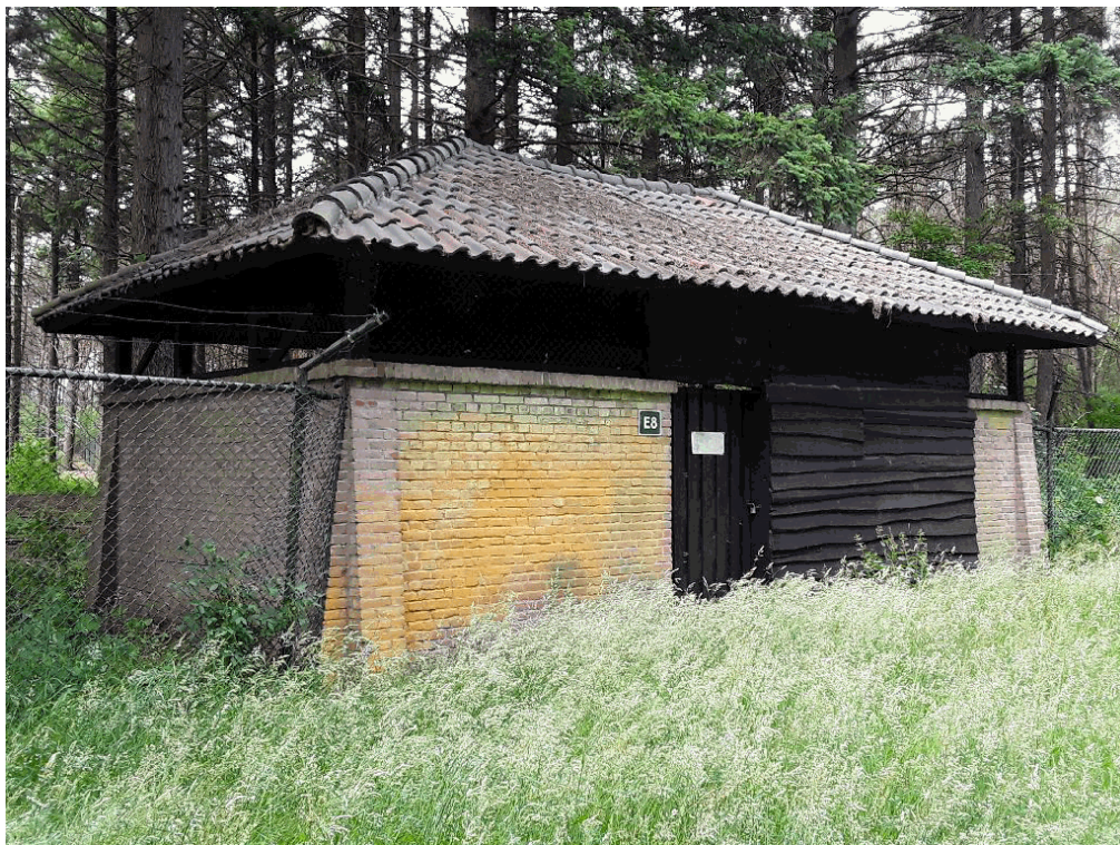
40B18E8, buitenzijde gebouw
