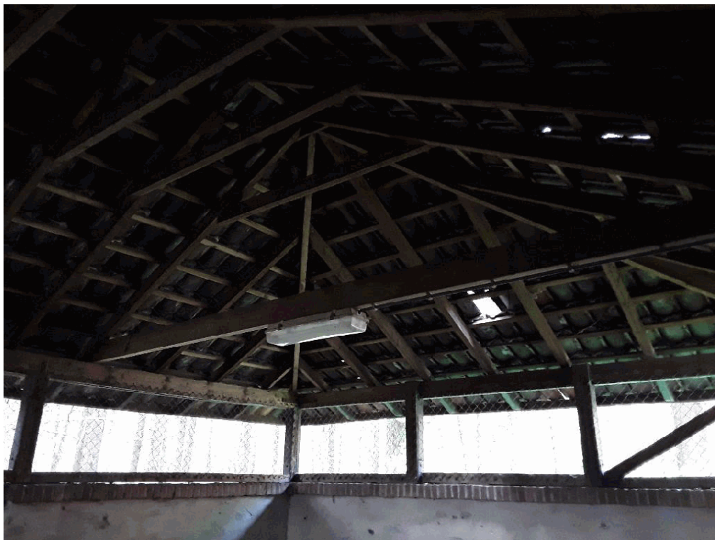
40B18E8, geen dakbeschot aanwezig
