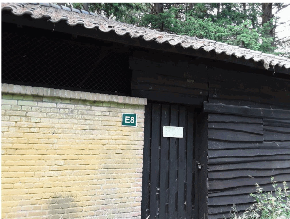
40B18E8, buitenzijde gebouw
