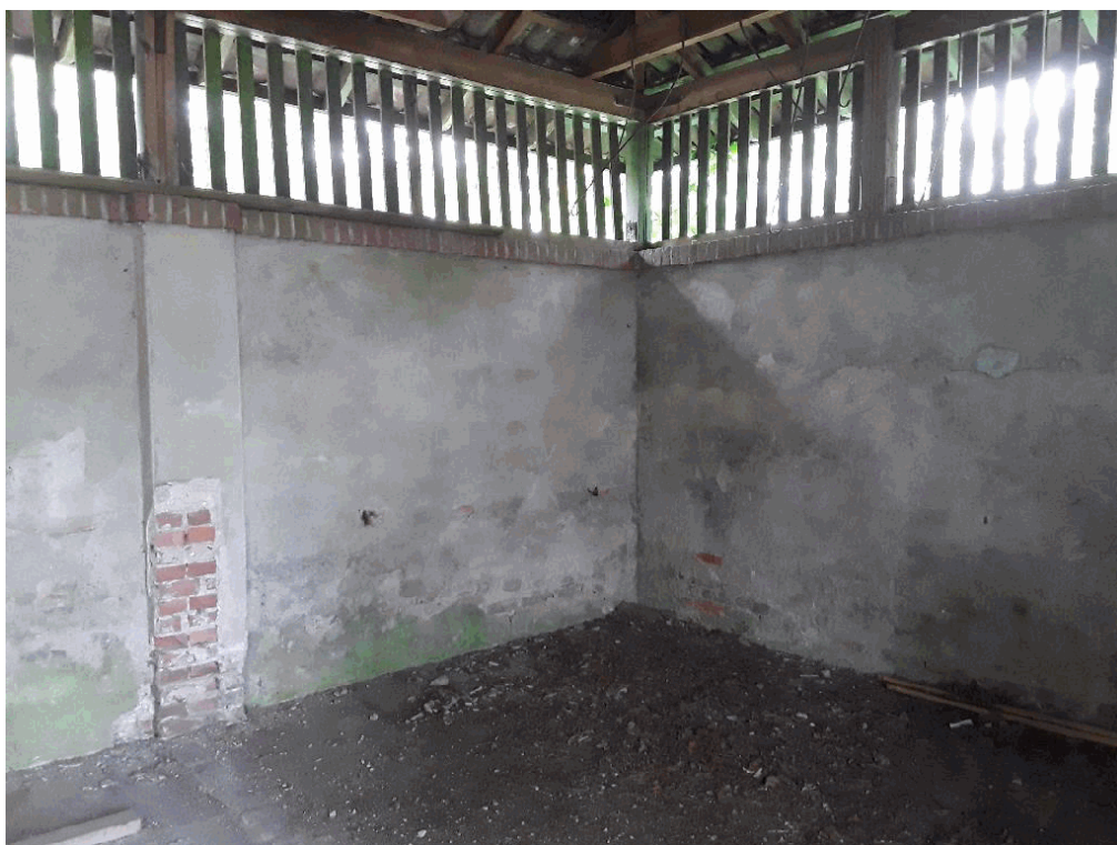
40B18E3, geen asbestverdachte materialen aanwezig binnenzijde gebouw.
