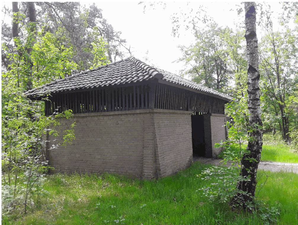
40B18E3, buitenzijde gebouw
