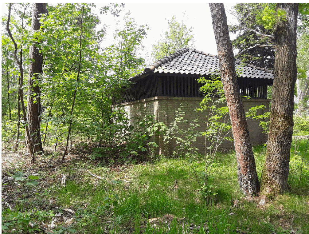
40B18E3, buitenzijde gebouw
