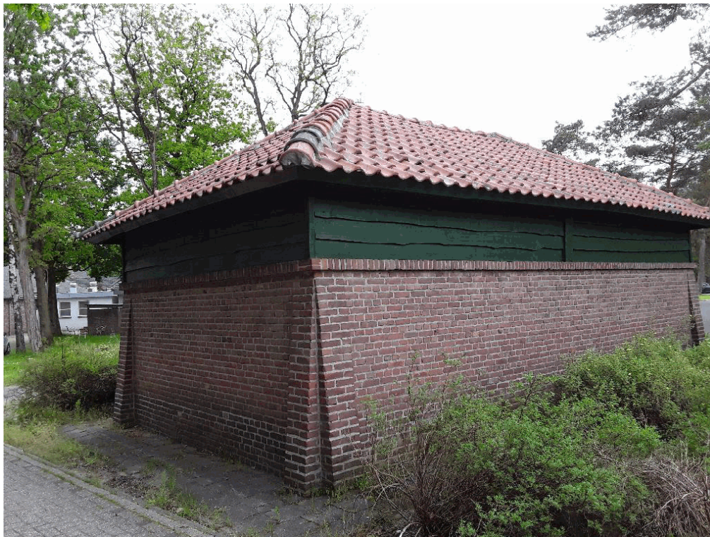
40B18E1, buitenzijde gebouw
