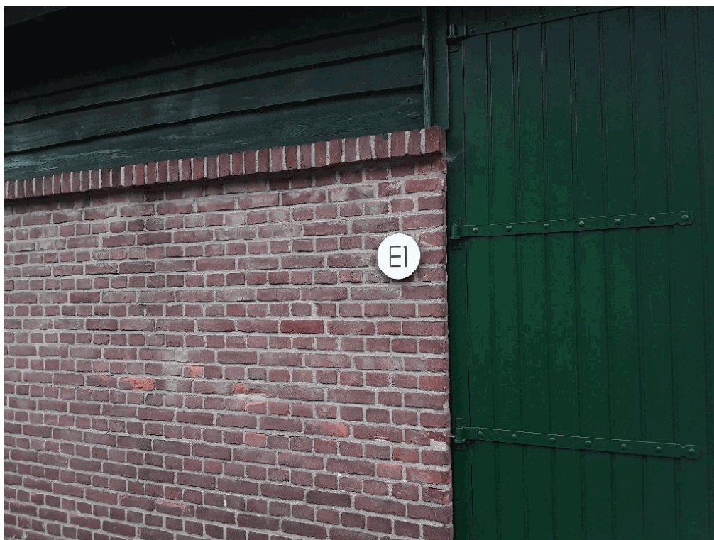
40B18E1, buitenzijde gebouw
