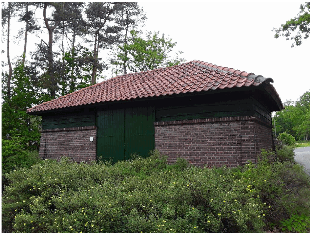
40B18E1, buitenzijde gebouw
