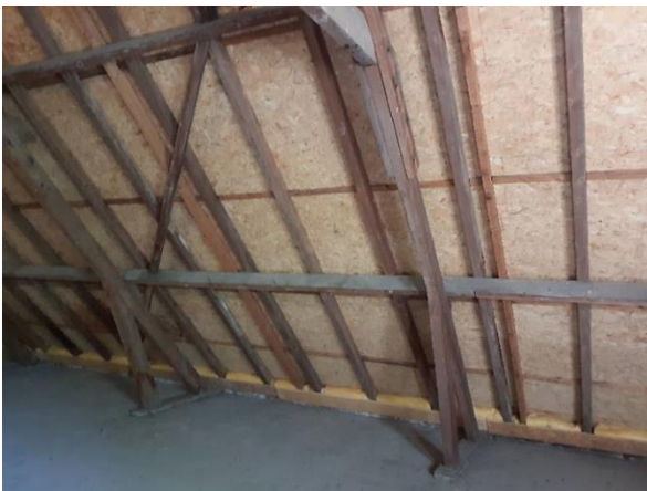
FB02: Het dakbeschot is niet asbestverdacht.
