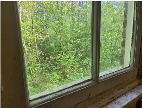
FB03: De beglazingskit en stopverf in de buitengevel is conform de oude rapportage niet asbesthoudend.
