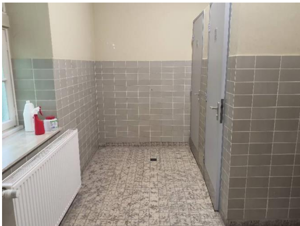
FB08: Achter het tegelwerk is geen inspectie mogelijk.
