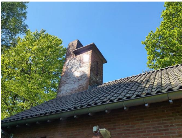
FB05: In het gemetselde kanaal is geen inspectie mogelijk.
