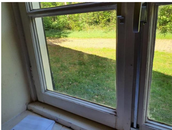
FB06: De beglazingskit en stopverf in de buitengevel is conform de oude rapportage niet asbesthoudend.
