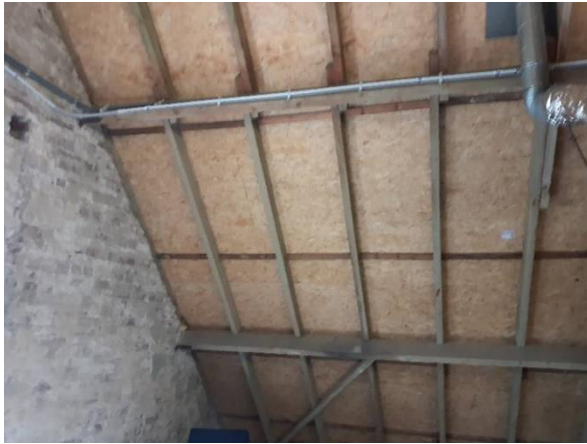
FB04: Het dakbeschot is niet asbestverdacht.
