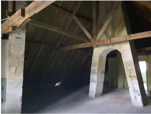
FB01: In de gemetselde kanalen is geen inspectie mogelijk.
