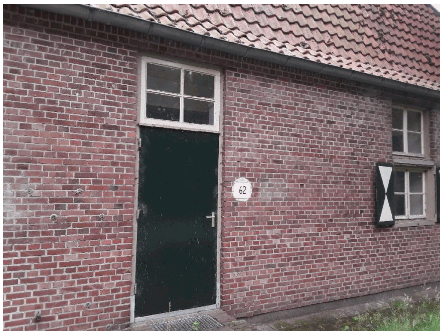
40B1862, buitenzijde gebouw
