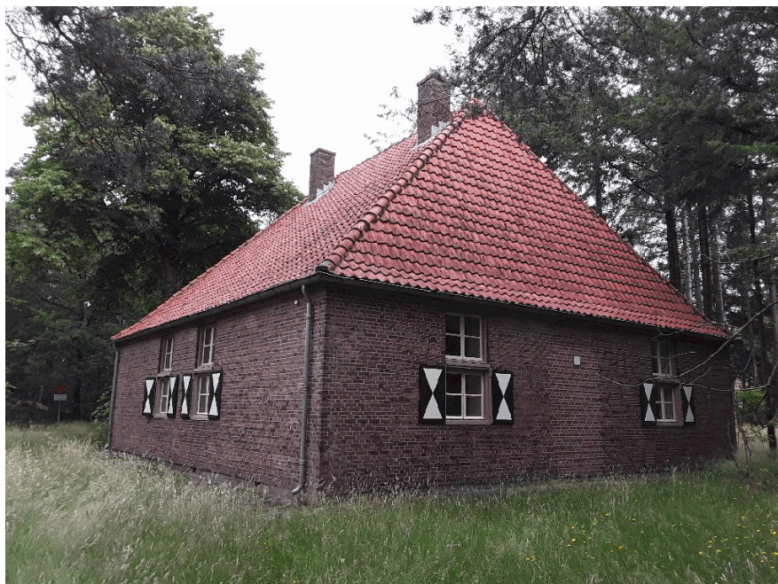
40B1862, buitenzijde gebouw
