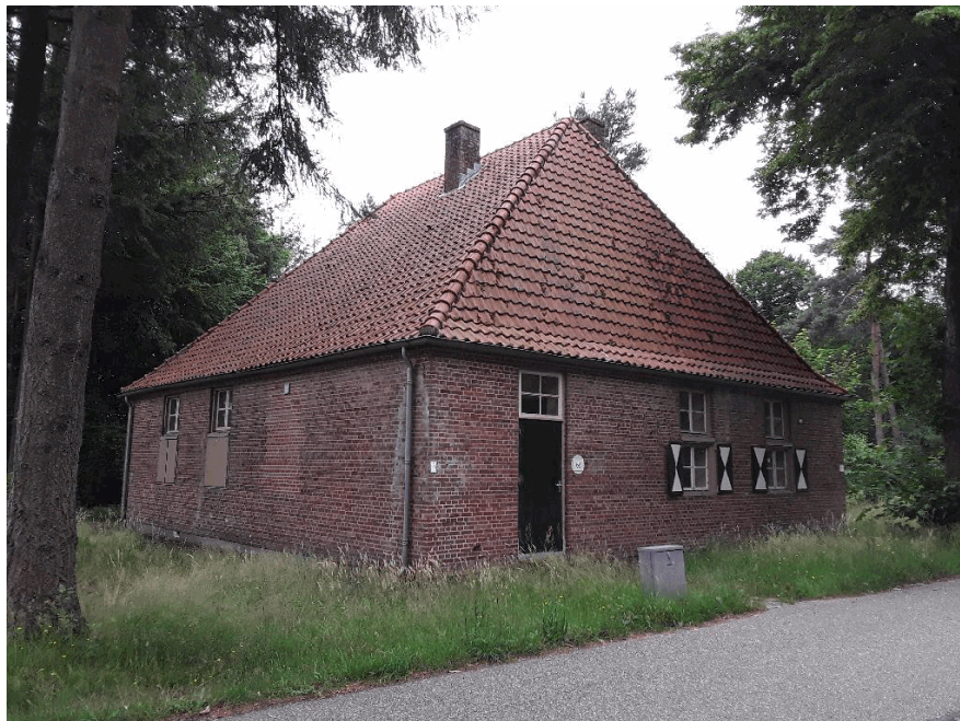
40B1862, buitenzijde gebouw
